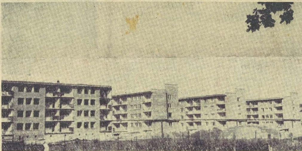
Coraz więcej nowych domów wyrasta w Lublinie. O osiągnięciach i kłopotach budowniczych kopalni miedzi przeczytajcie w następnym numerze „Wiadomości”. fot. Romuald Nader
