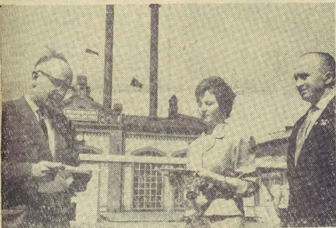
Po meldunku o gotowości fabryki do rozruchu, list Ministra Przemysłu Ciężkiego skierowany do zarządu „Kablów” odczytał dyrektor Zjednoczenia Przeniosu Kabli i Sprzętu Elektroenergetycznego mgr inż. Cyprian Niewiadomski. Z prawej dyrektor naczelny Legnickiej Fabryki Przewodów Nawojowych Zdzisław Franasz, w środku Halina Kryston.
