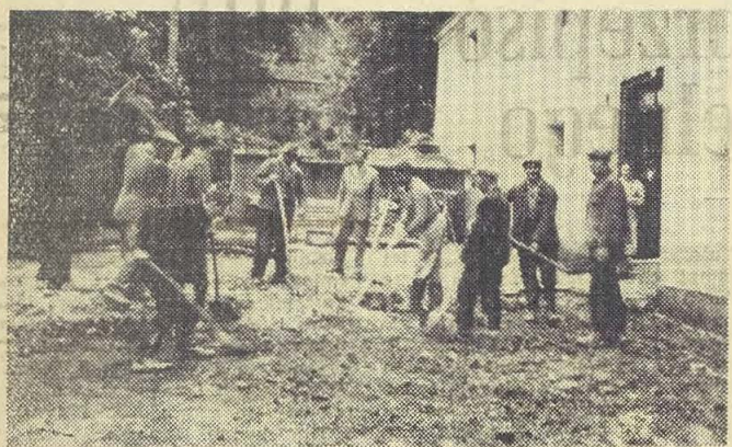
Do prac porządkowych w Wądrożu wiejskim, o czym pisaliśmy w poprzednim numerze „Wiadomości”, przyjechały jednostki Ochotniczej Straży Pożarnej z Granowic (14 osób) i Kęp (13 osób). Na zdjęciu OSP z Granowic na czele z komendantem Antonim Grygorewiczem przy porządkowaniu placu obok Banku Spółdzielczego.
