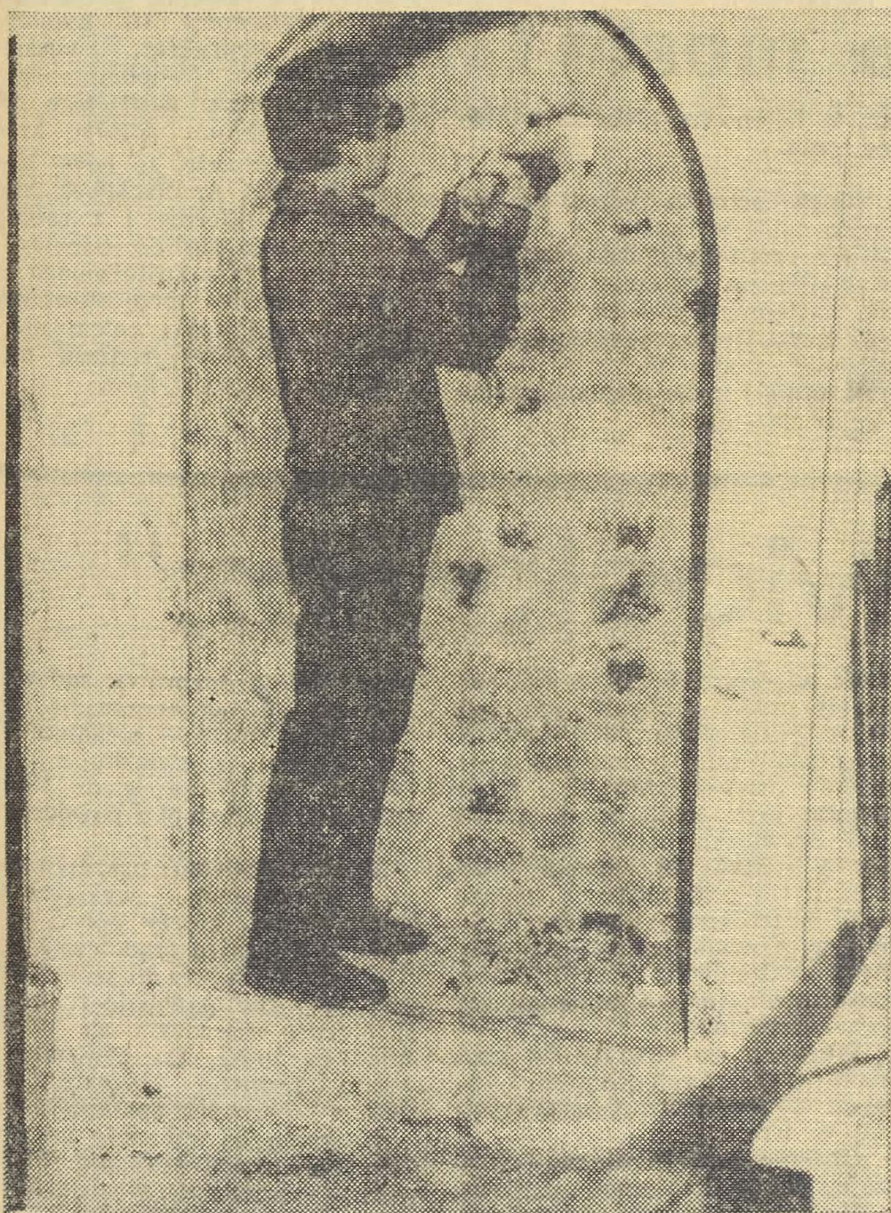
Pomiar temperatury stożków pirometrycznych u wejścia do pieca jest bardzo odpowiedzialnym zadaniem. Na zdjęciu Ferdynand Strzyżek przy pomiarze. W piecu znajduje się około 10 ton gliny szkieł wurobów.
