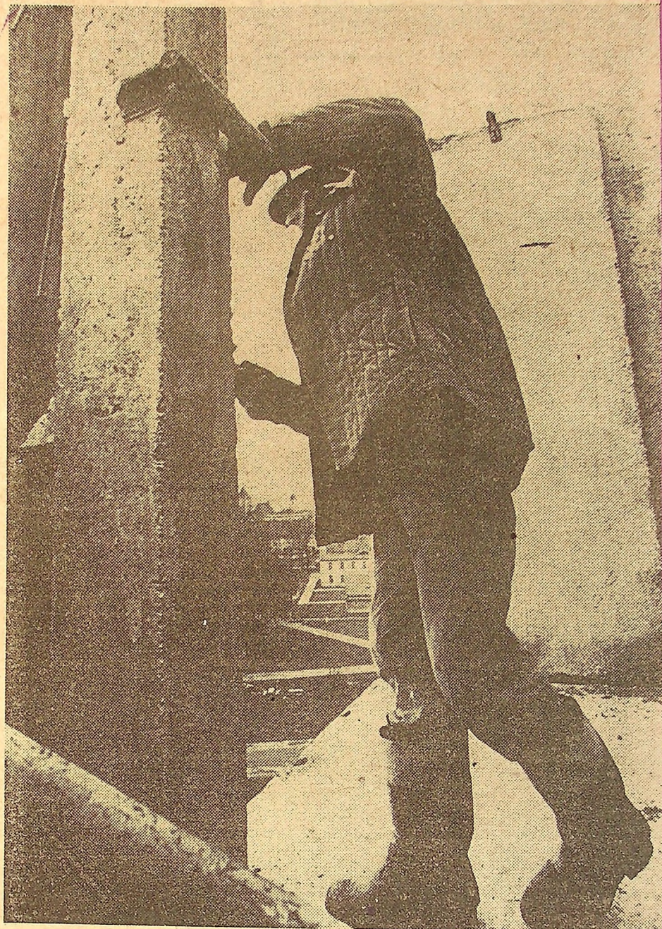
Montażysta Jan Bojek wykuwa otwory na ustawienie ścianki loggi już podczas montażu. Fot. Krzysztof Raczkowiak
