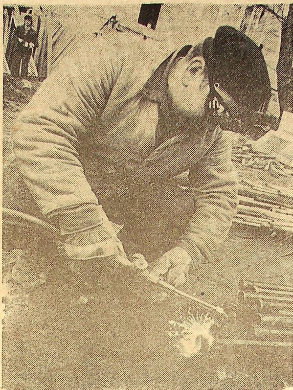
Brygadzysta Jan Matyjas przygotowuje rury do montażu instalacji c.o.
