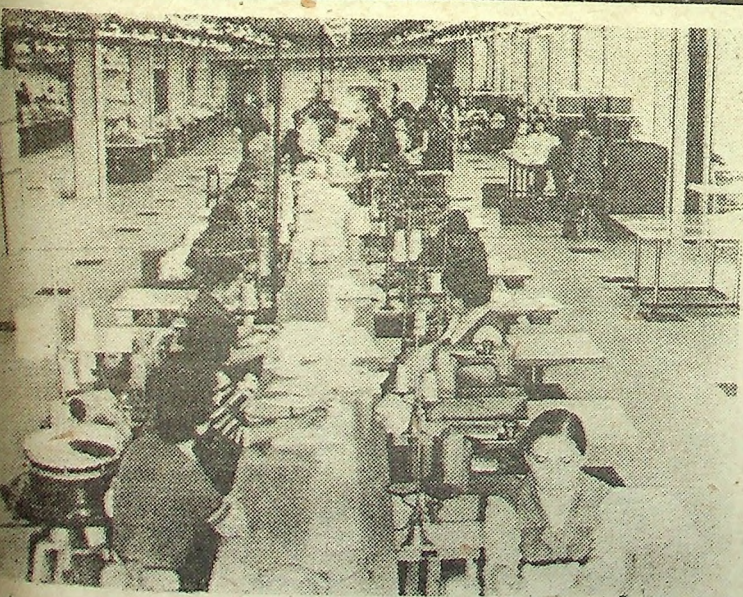
Budynek filii „Milany” w Głogowie kosztował 80 mln zł, park maszynowy 100 mln zł. Zakład w zasadzie jest już całkowicie uruchomiony w części technicznej, ślamazarni budowlani naprawiają jeszcze usterki.
