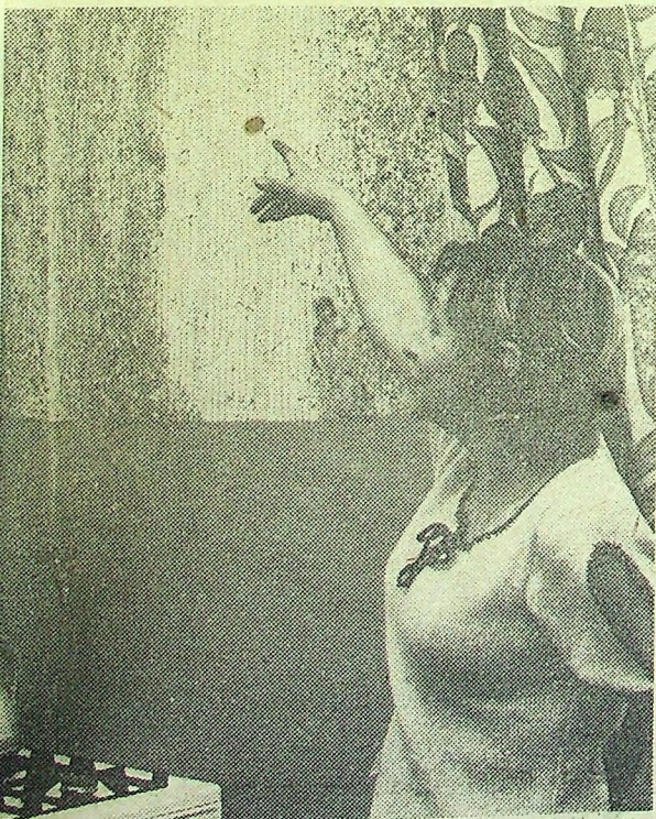
marznące ściany w jednym z mieszkań budynku „F” na osiedlu
