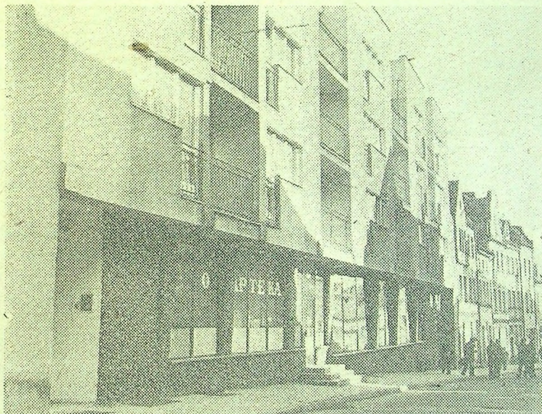
Budynek przy ulicy 23/30 w Złotoryi cieszy oko estetyczną architekturą i elewacjami. Oprócz 21 mieszkań mieści również obszerną, potrzebną mia- stu aptekę.
