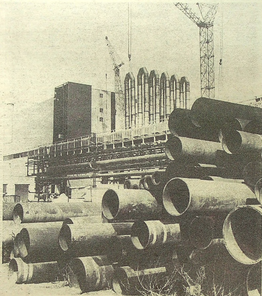
„Głógów II” to ciągle wielki plac budowy. Nikogo nie dziwi widok rur, płyt, blachy. Materiały te ciągle są potrzebne dla szybko postępujących prac budowlanych i montażowych.
