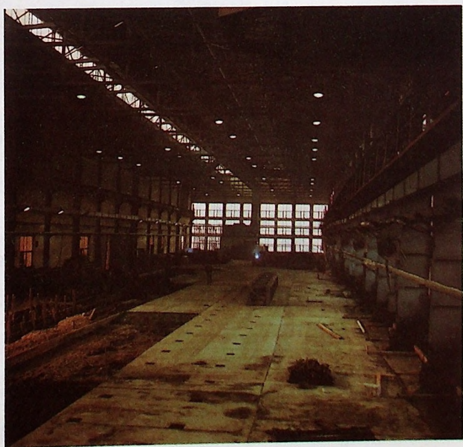
W Nowym Kościele modernizuje się halę dla Wydziału Montażu — ma być uruchomiona na „Barbórkę”
