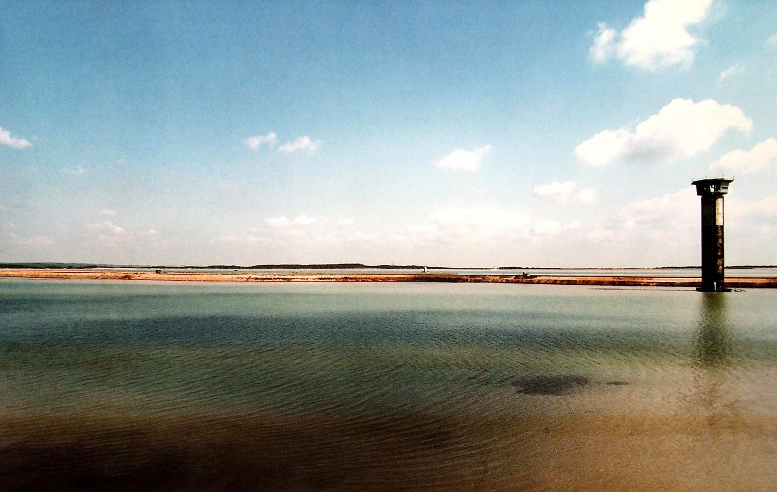
■ Wieża przelewowa do odprowadzania nadmiaru wód nadosadowych w osadniku „Żelazny Most”
