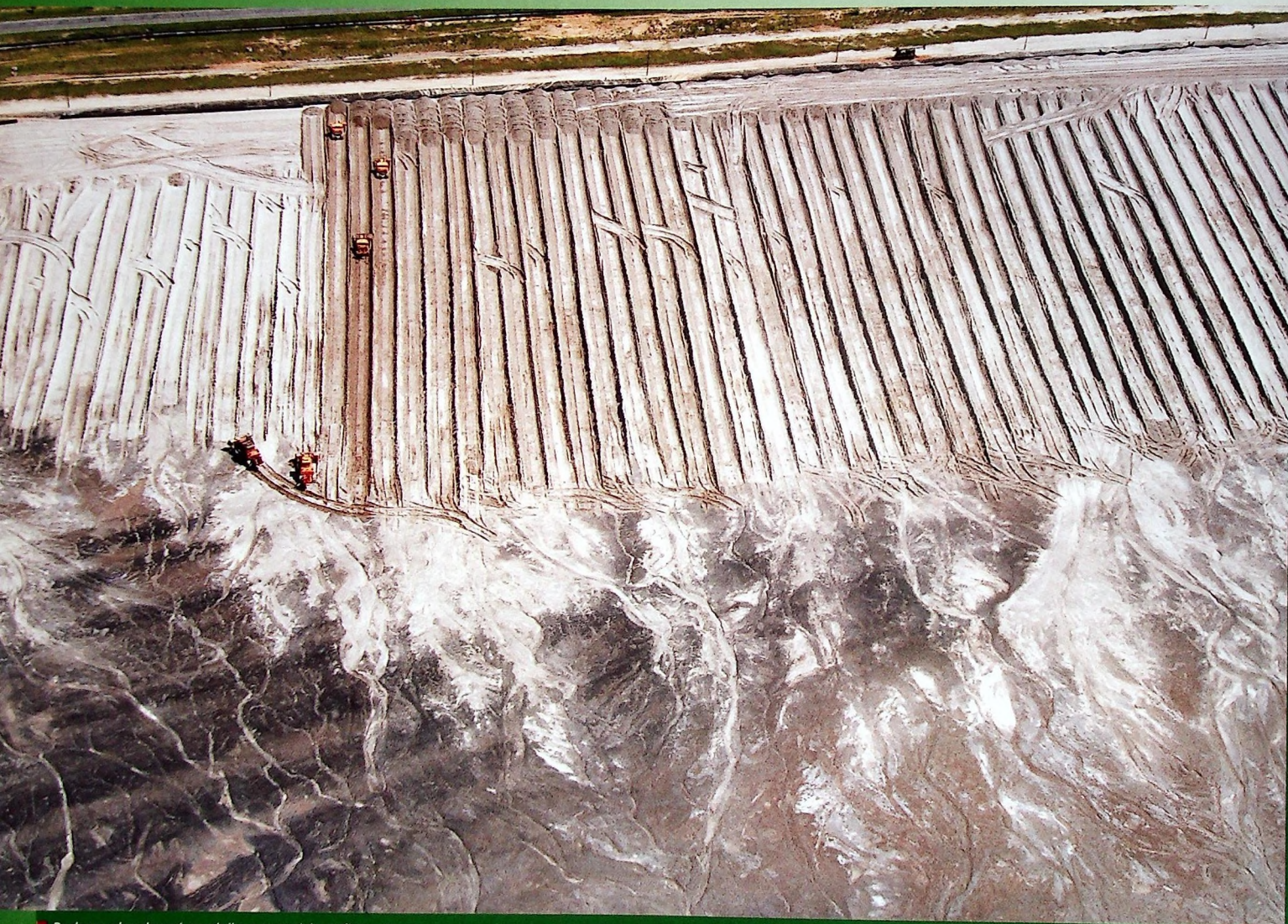
■ Budowa obwałowań osadnika z materiału poflotacyjnego
