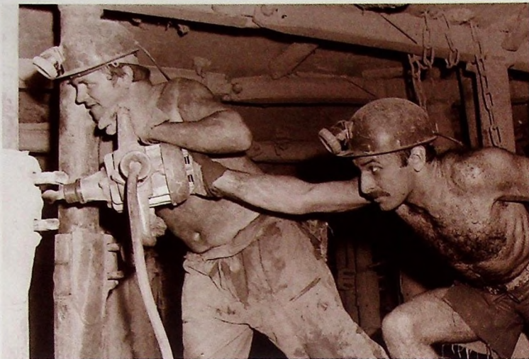
■ Wiercenie otworów strzałowych
