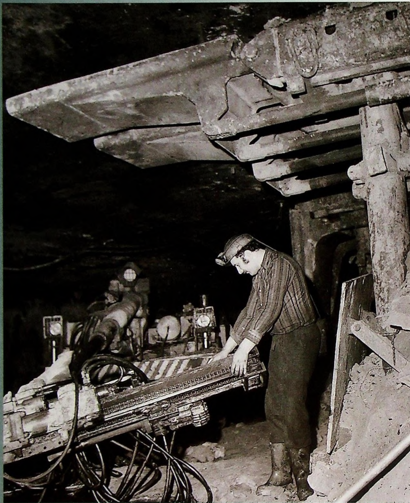
■ Próba wprowadzenia obudowy hydraulicznej Hemscheidt
