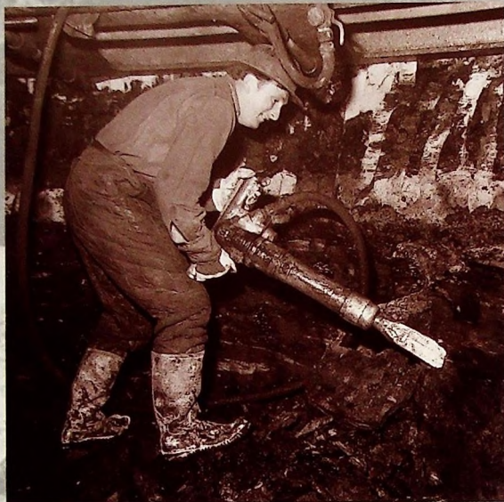
■ Urabianie zamrożonego górotworu
