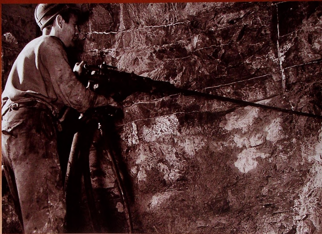
■ Wiercenie otworów strzałowych
