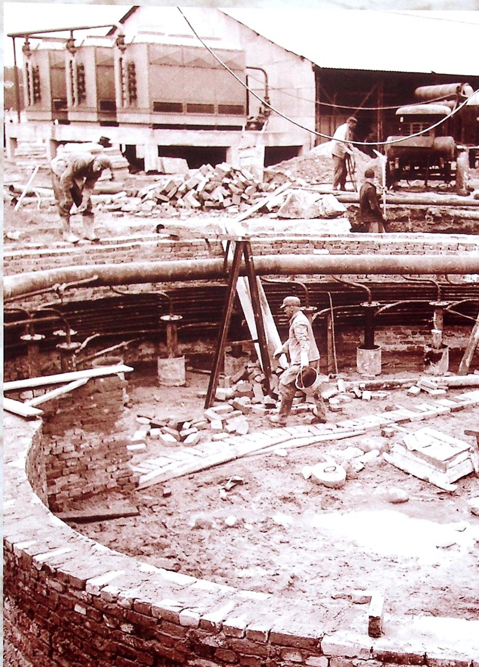
■ Piwnica mrożeniowa szybu
