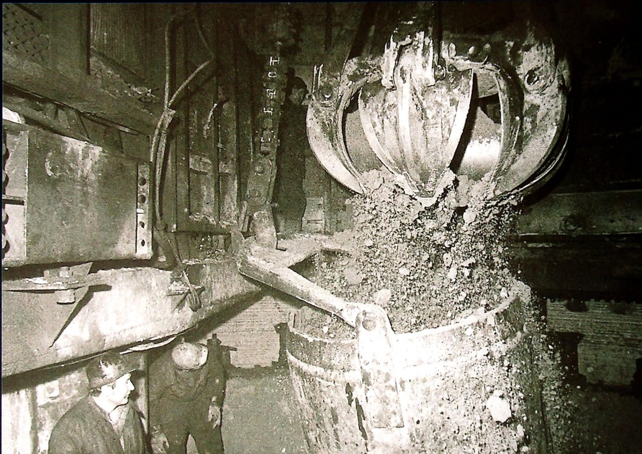
■ Ładowanie urobku przy pomocy ładowarki szybowej
