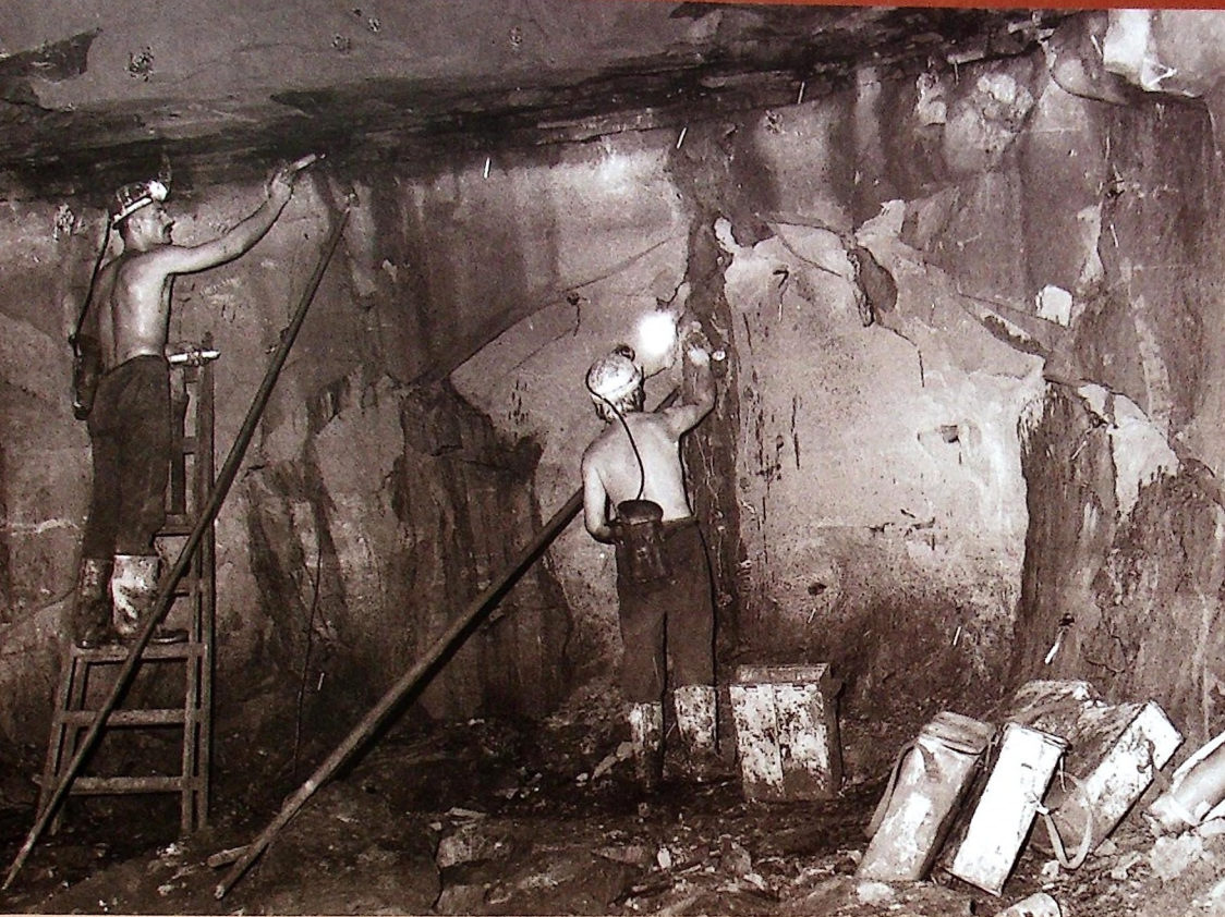
Zakładanie ładunków do otworów
