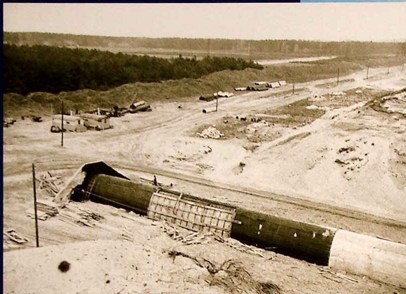
■ Budowa tunelu do odprowadzania wód nadosadowych z osadnika „Gilów”
