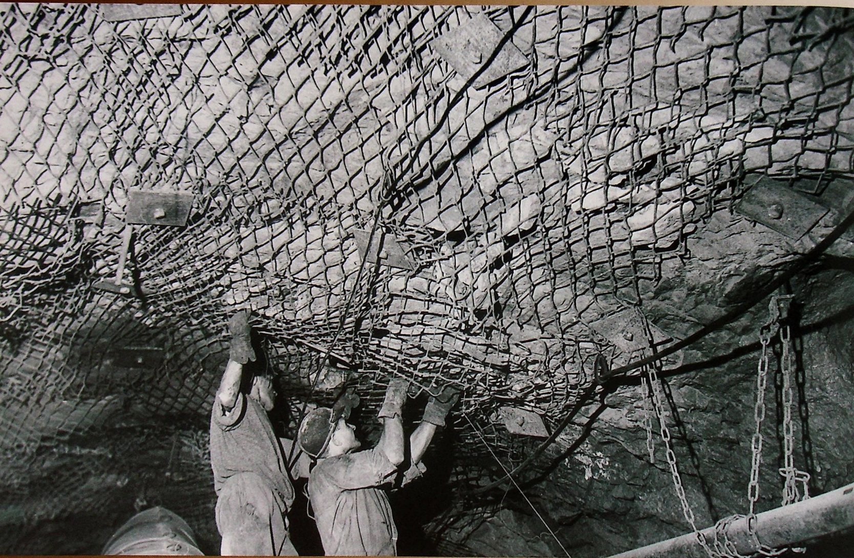
■ Zabezpieczanie stropu siatką stalową
