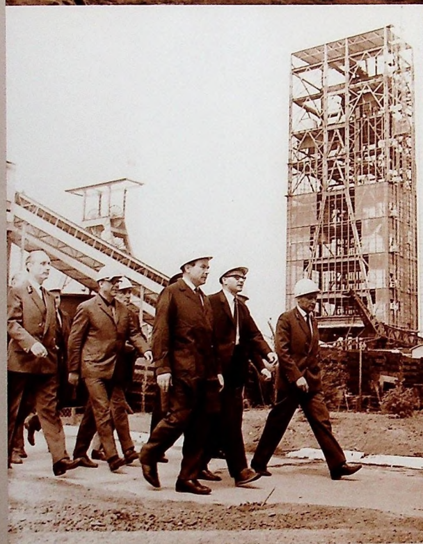
■ Budowa szypów głównych kopalni „Polkowice”
