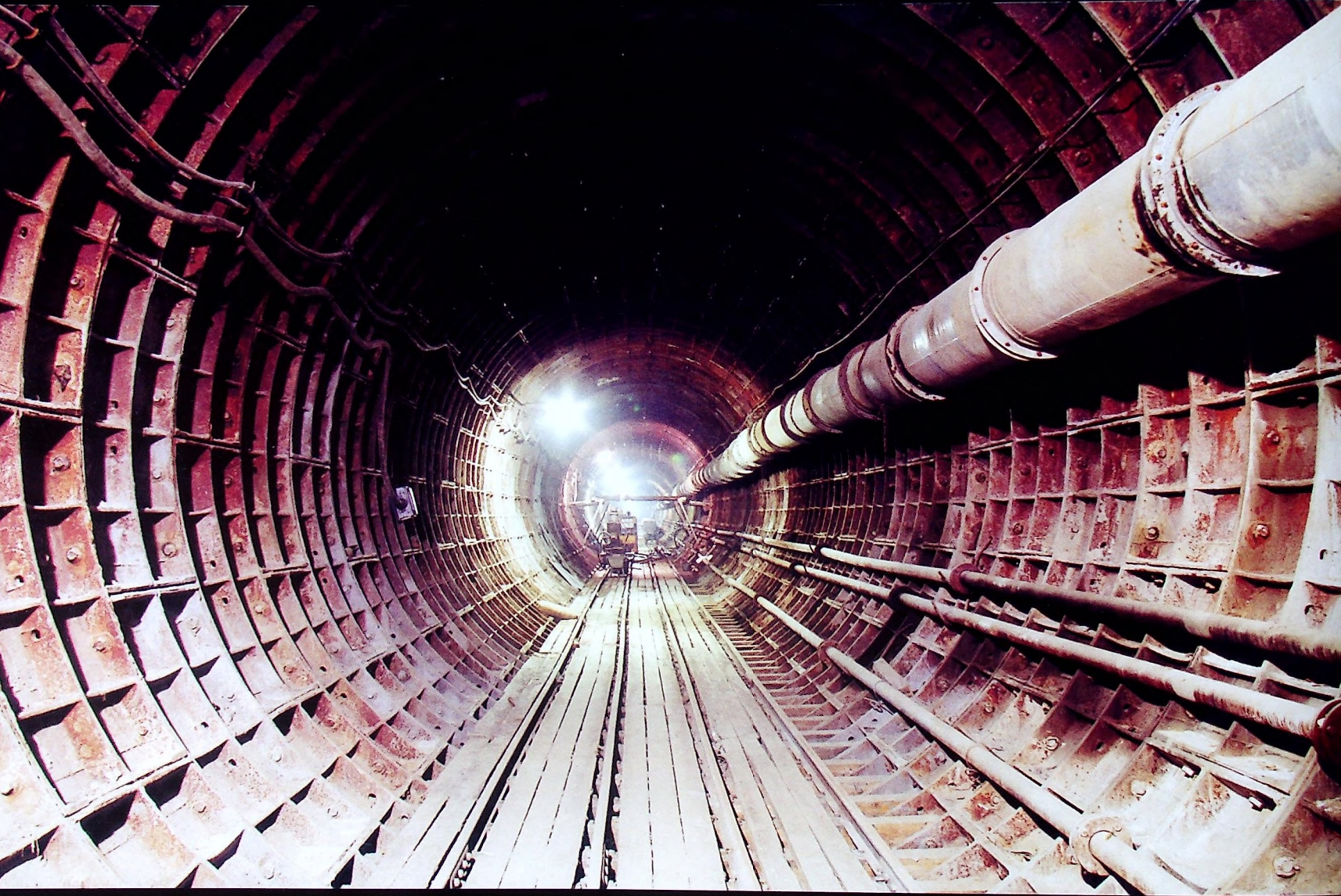
■ Jedną ze specjalności PeBeKa – budowa tuneli
