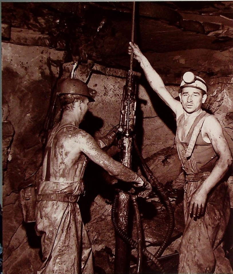
■ Wiercenie otworu kotwiowego
