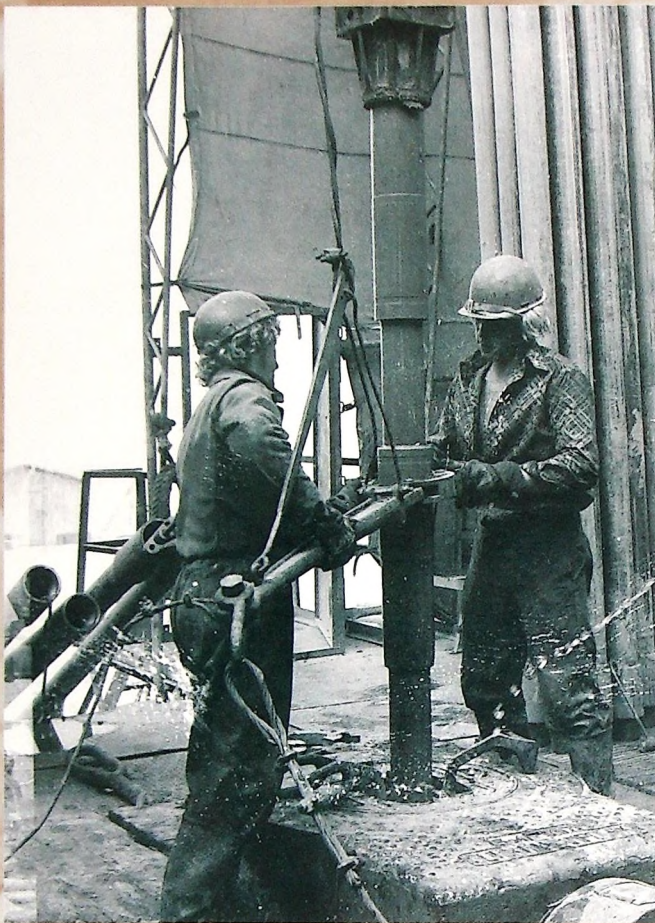
■ Wiercenie otworów mroźniowych
