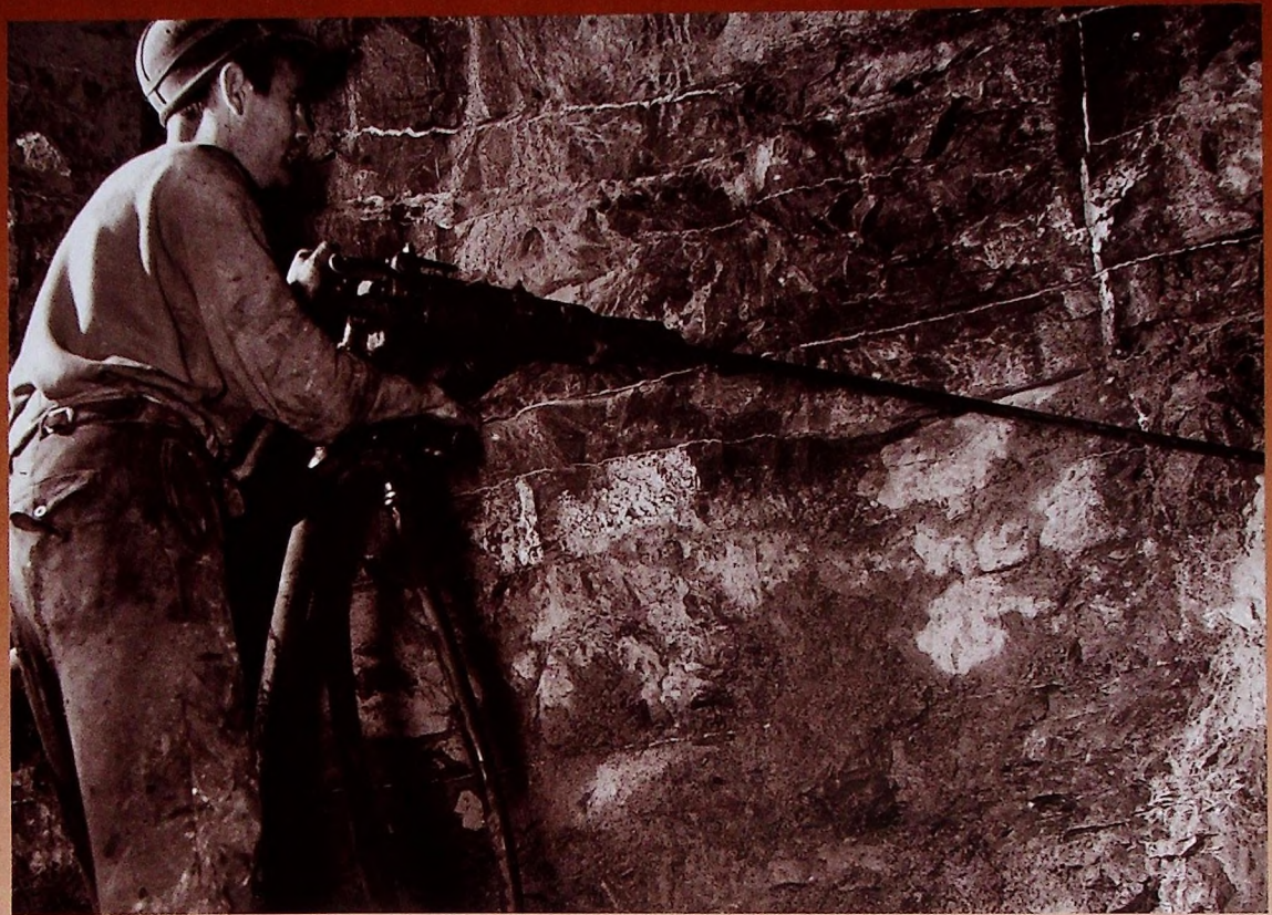
■ Wiercenie otworów strzałowych
