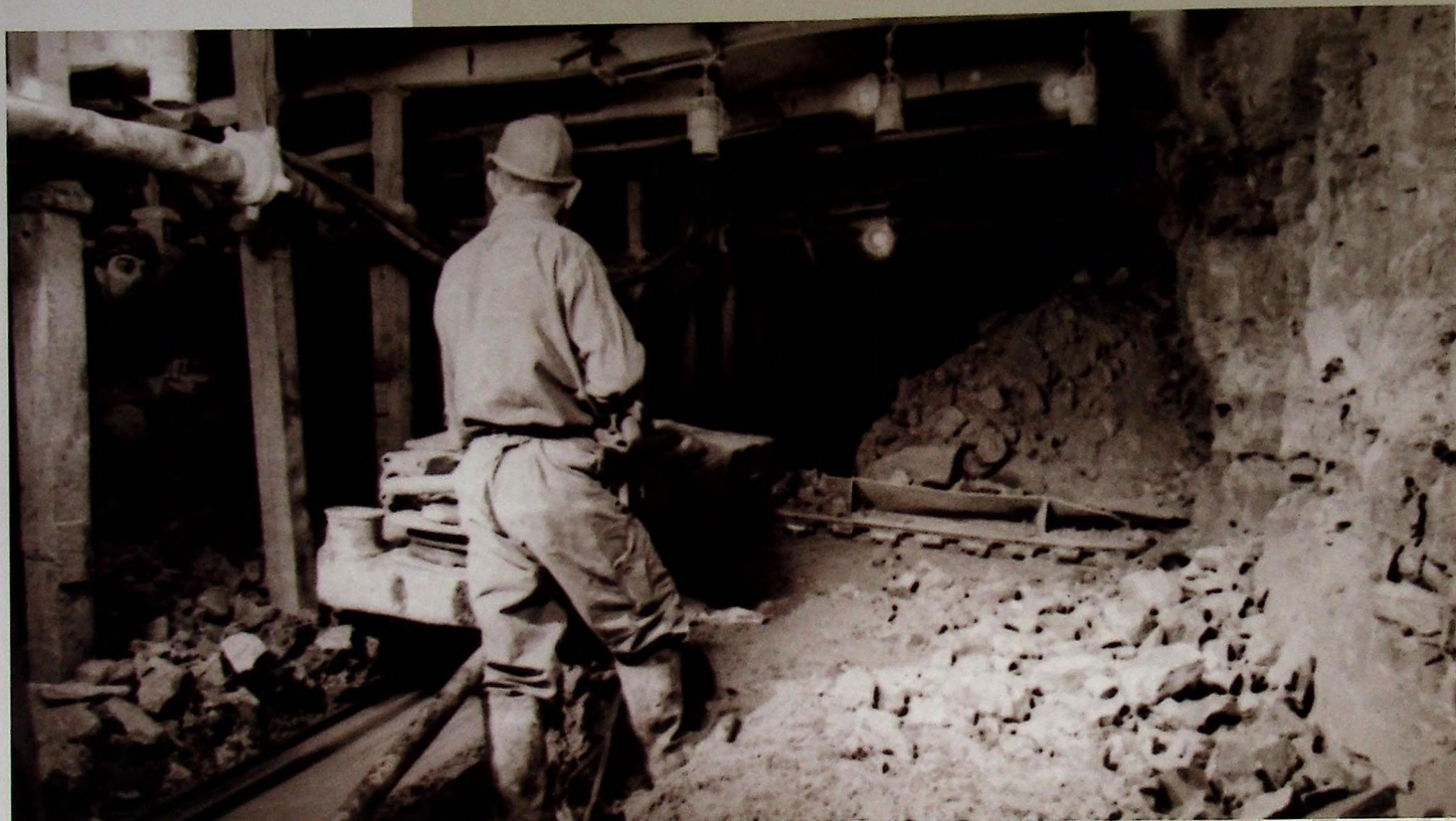
■ Ładowanie urobku przy pomocy wręboladowarki
