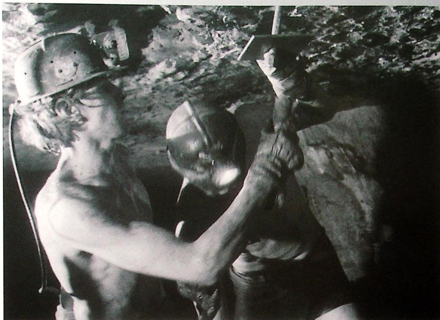
■ Ręczna zabudowa kotwi
