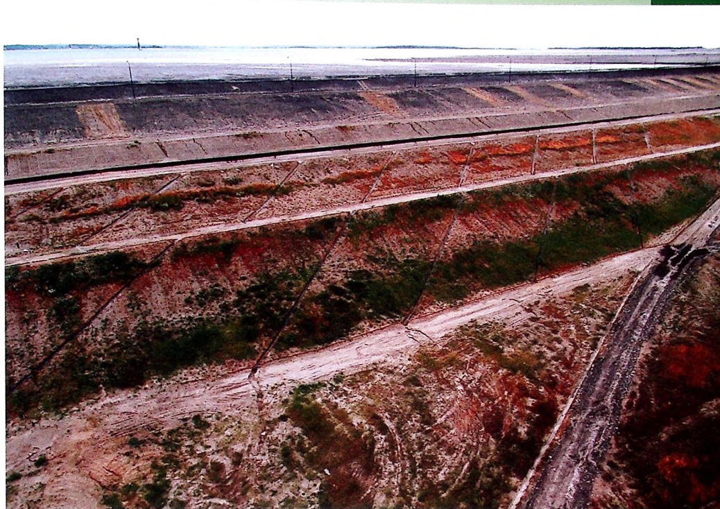
■ Skarpa zapory osadnika „Żelazny Most”
