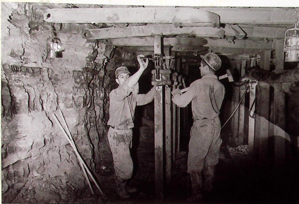
■ Montowanie obudowy
