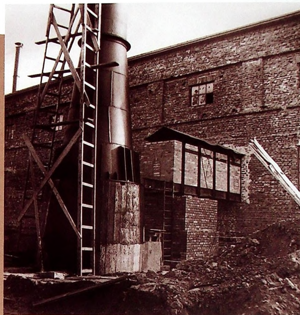
■ Komin pieca wirebarsowego
