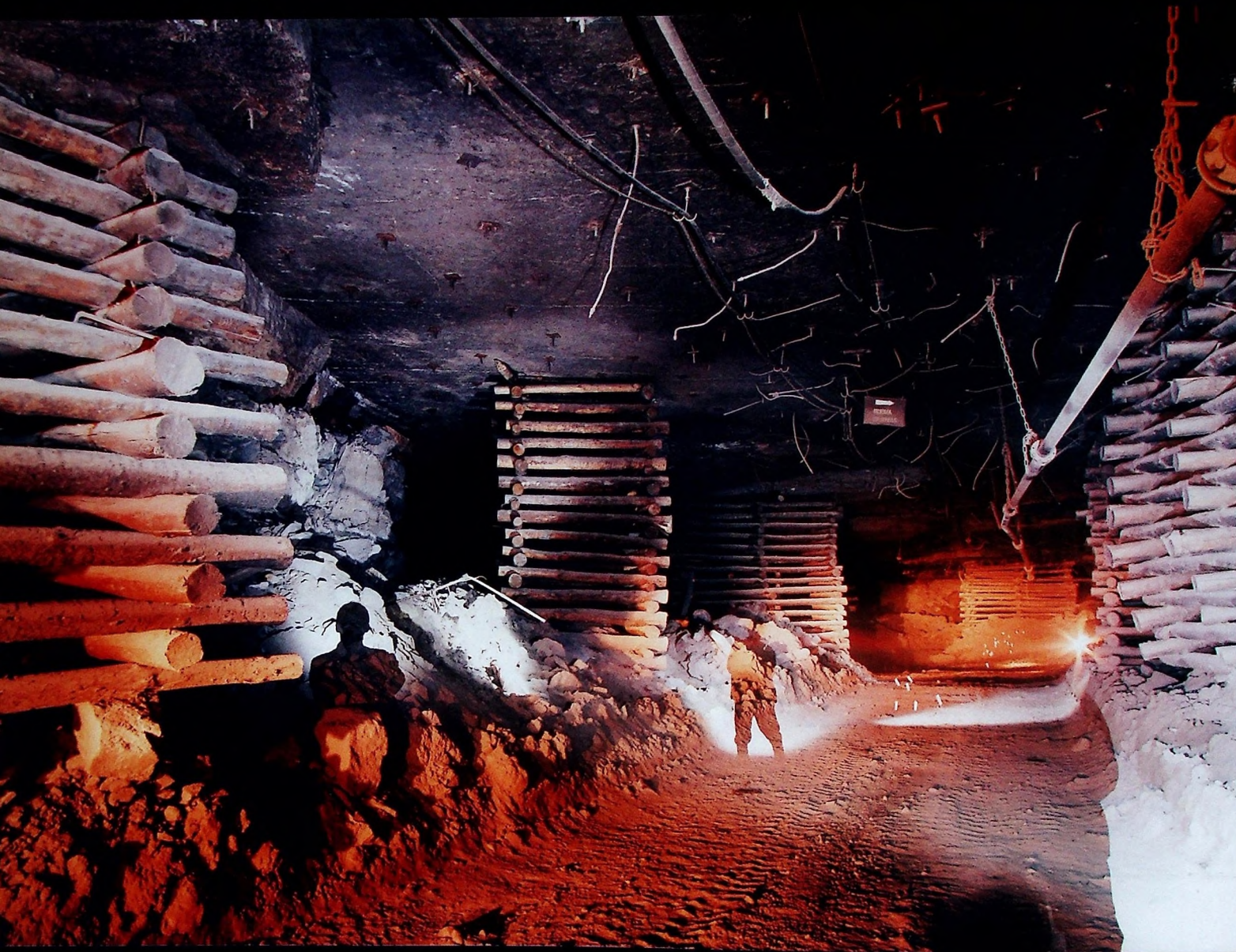
■ Nawet w nowoczesnej kopalni stosowana jest obudowa kasztami drewnianymi
