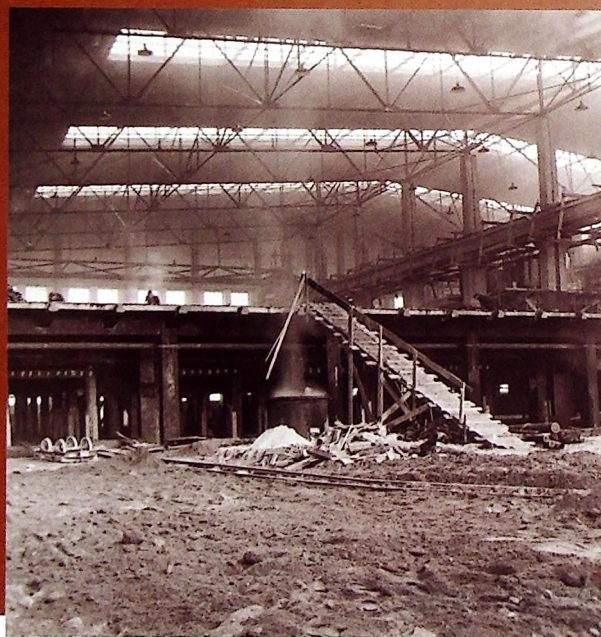
■ Budowa hali elektrolizy
