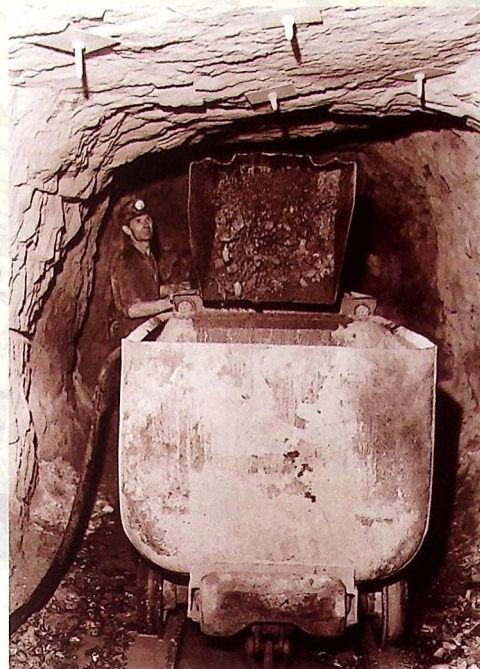
■ Ładowarka zasięrzutna i wóz odstawczy używane w początkach budowy kopalń „Lubin” i „Polkowice”
