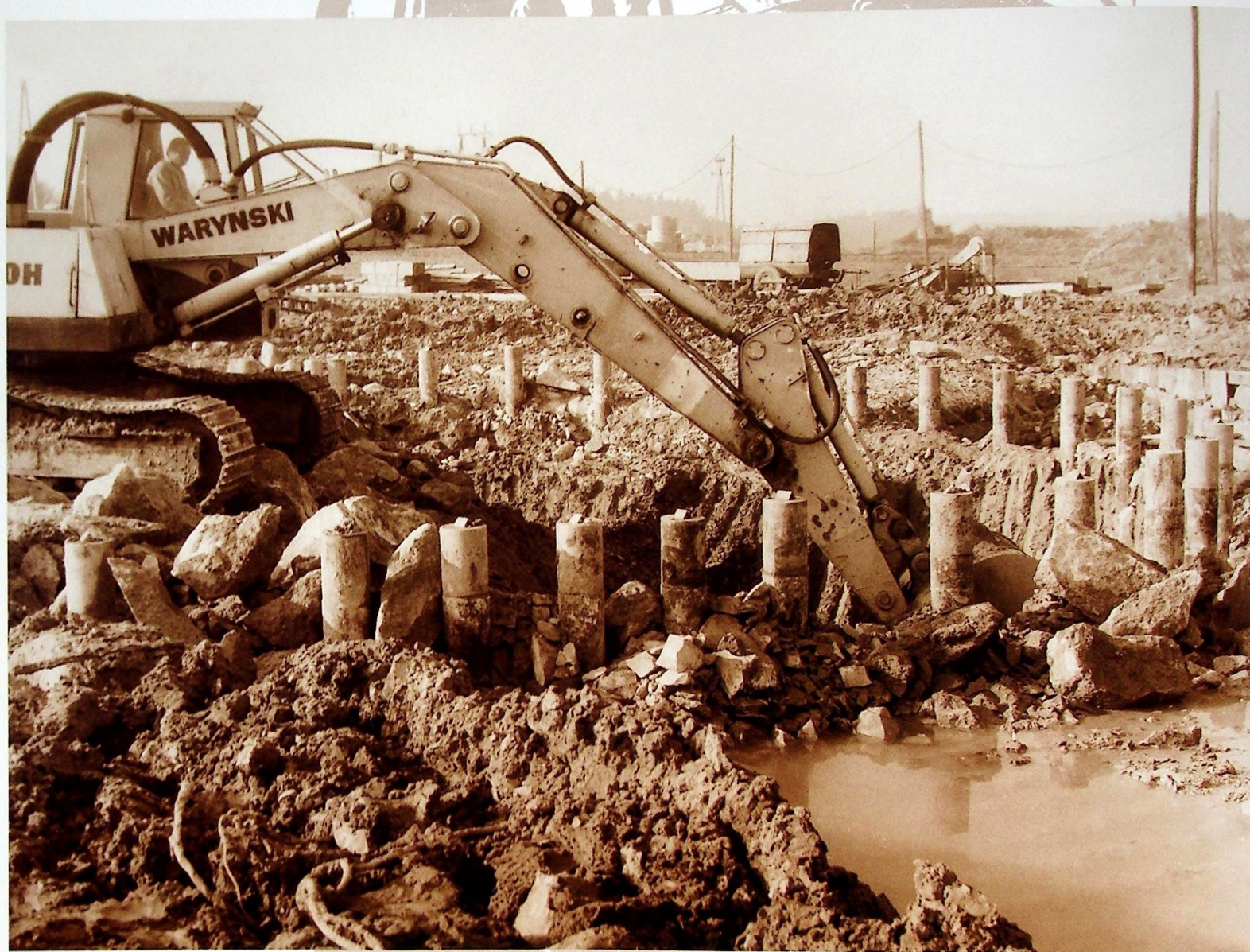
■ Początki budowy najmłodszej kopalni „Sieroszowice”
