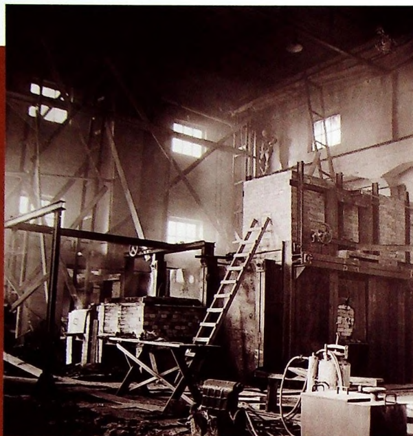
■ Budowa pieca wirebarsowego
