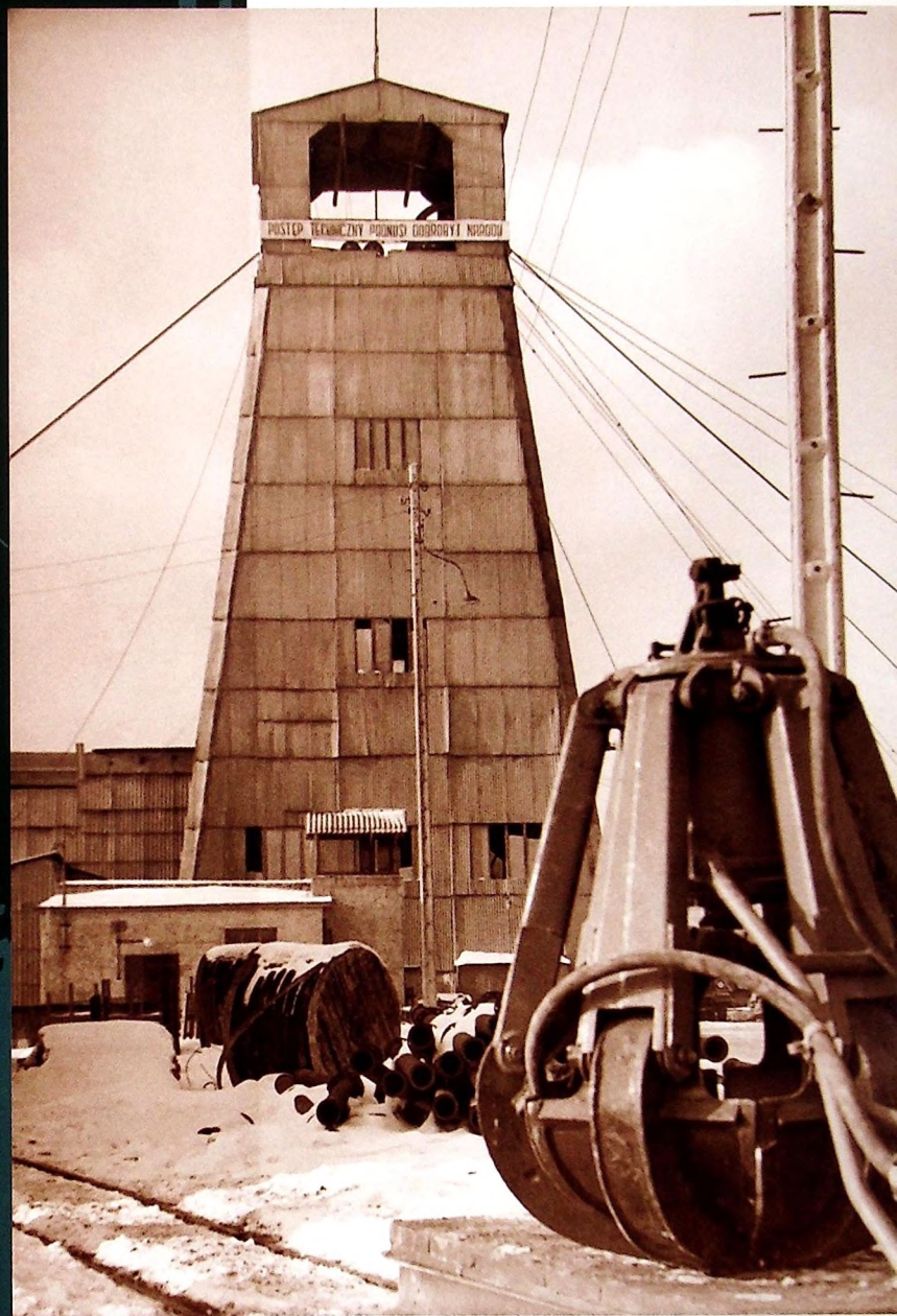
■ Tymczasowa wieża szybowa, obok ładownia szybowa
