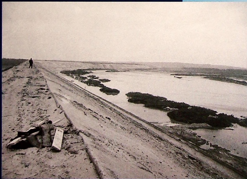
■ Końcowa faza budowy osadnika „Gilów”
