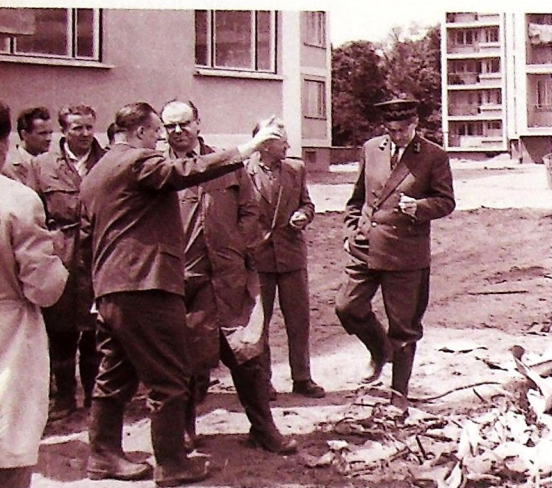
Budowa zakładowych mieszkań przy lubińskim rynku
