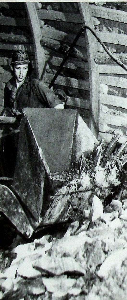
Drażenie chodnika w obudowie łukowej ŁP
