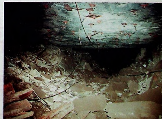
Wypiętrzenie spągów po tąpnięciu w oddziale G-9
