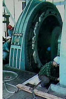
Modernizacja maszyny wyciągowej na wieży skipowej szybu L-II
