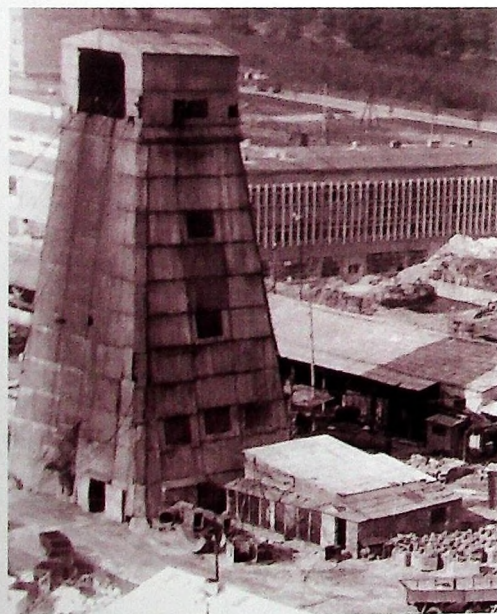
Budowa szybu L-II (w tle ZWR)
