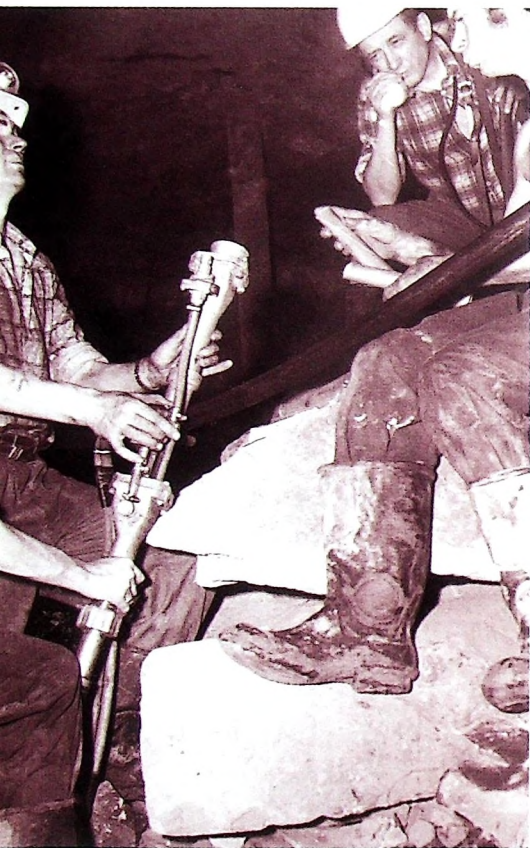
Ładowanie MW ładownicą TA-32c otworów zawalowych
