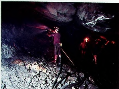
Ręczne wiercenie otworów strzałowych wiertarką WUP-22
