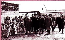
Dzień powszedni budowy
