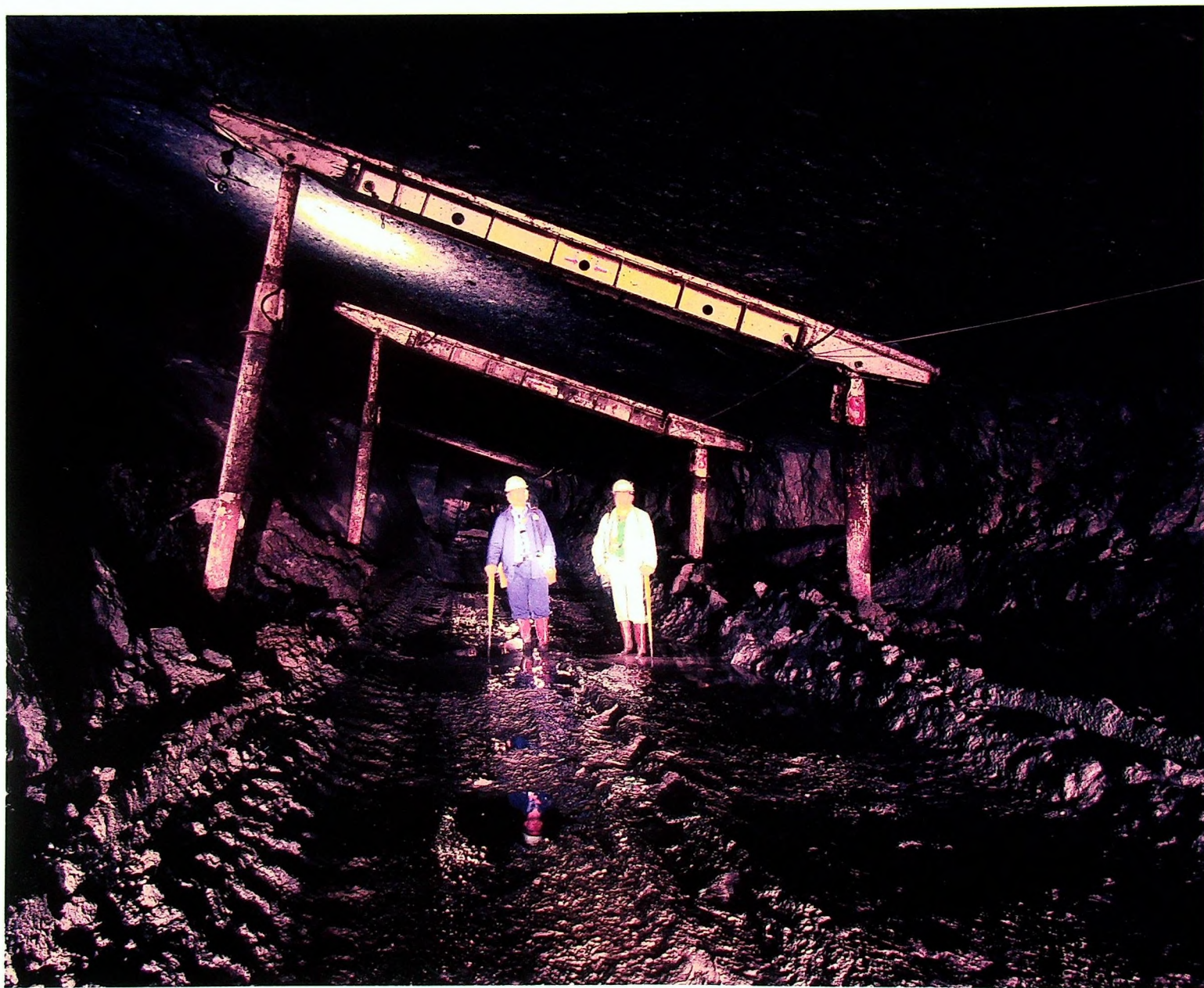
Hydrauliczna obudowa podporowa w rejonie pochytego złoża w oddziale G-5. A. Niechwiej i W. Wachlarz.
