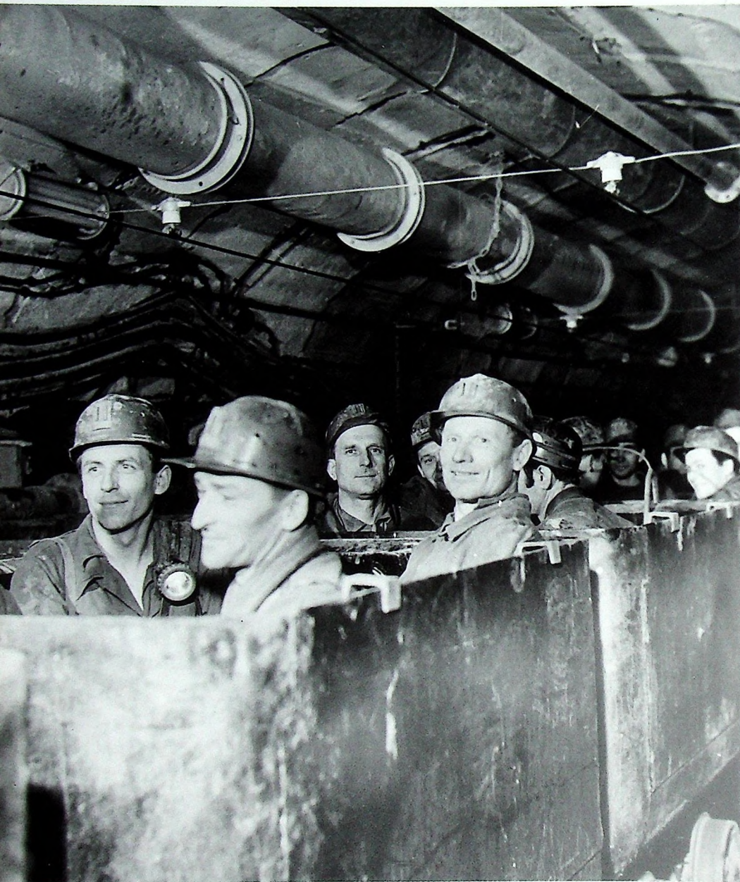
W okresie budowy kopalń dowóz załogi odbywał się wozami urobkowymi
