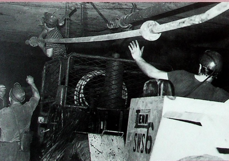
Montaż rurociągu do „przepłuczki”
