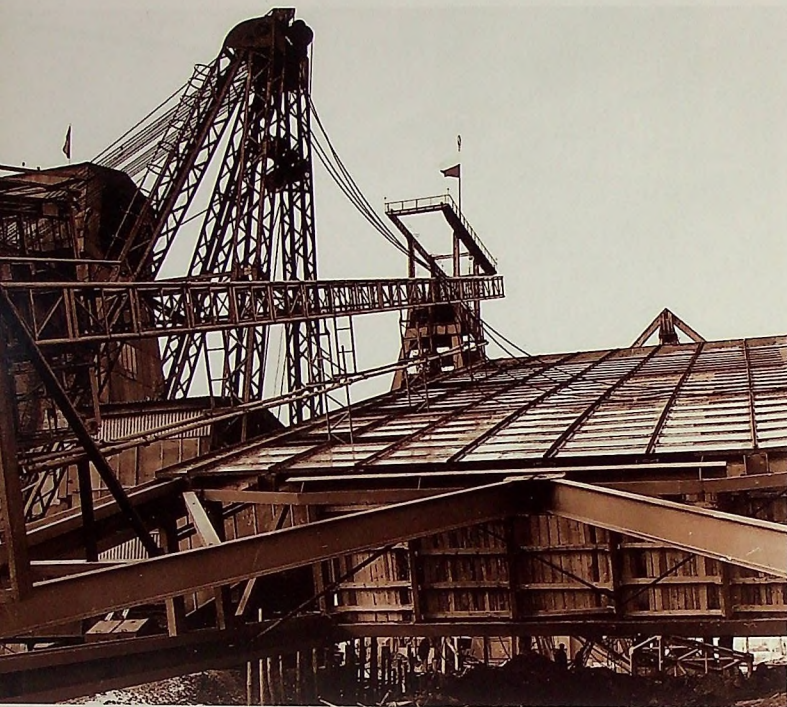
▲ Podnoszenie fragmentu konstrukcji szybu skipowego
