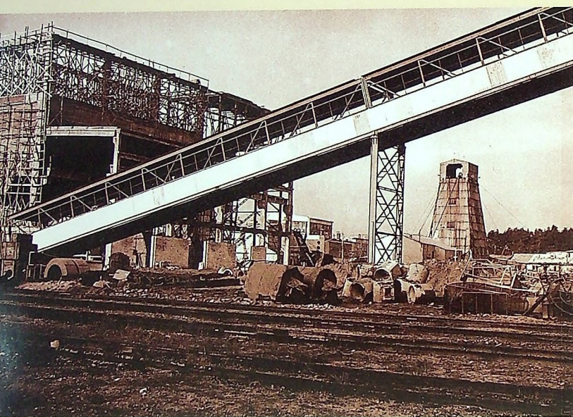
▲ Budowa Zakładu Mechanicznej Przeróbki Rudy Miedzi
