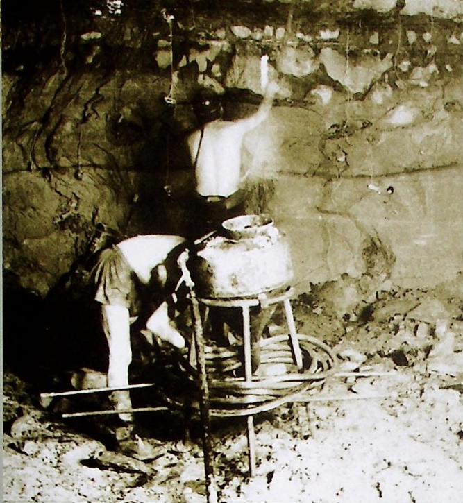
► Ładowania materiału wybuchowego przy pomocy urządzenia „Nikol”
