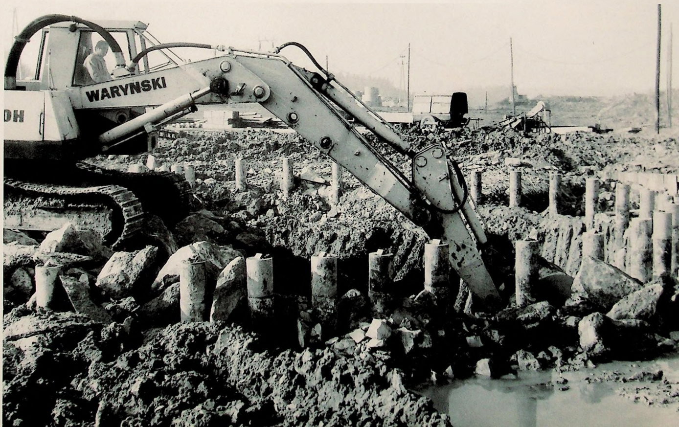
▲ Pierwsze prace przy budowie szybu SW-1
