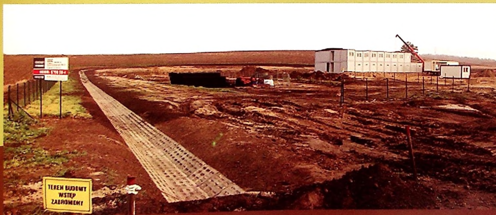
Plac budowy szybu SW-4
