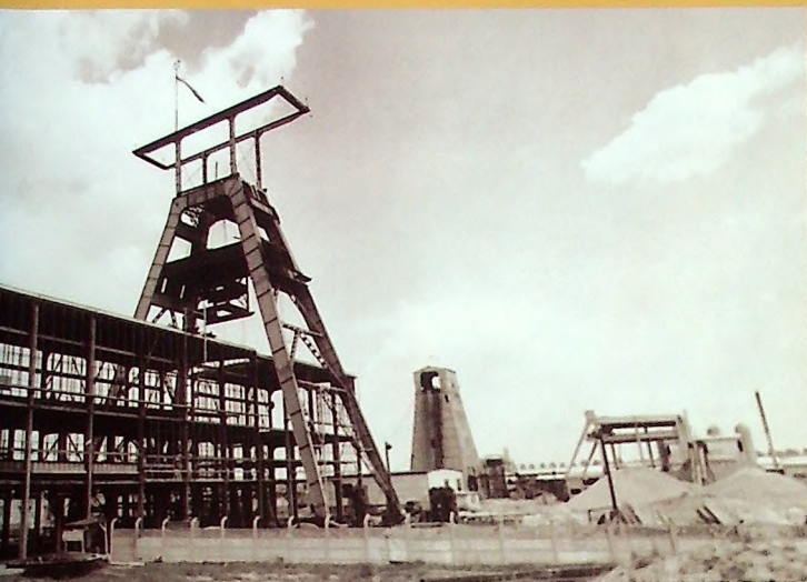
▲ Kolejne fazy montażu wieży szybowej i nadszybia PG-I
