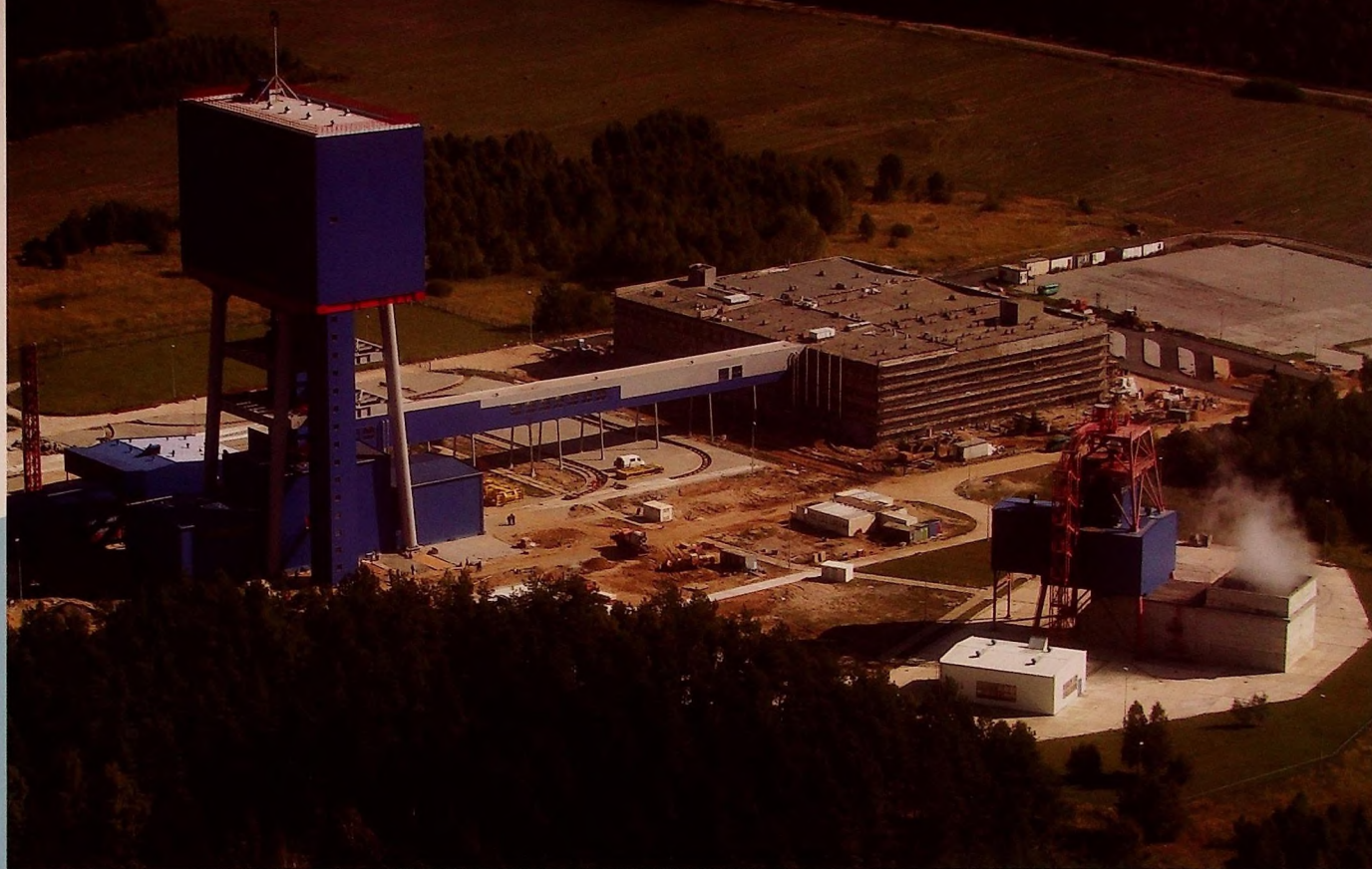
▲ Budowa kompleksu szybowego SG
