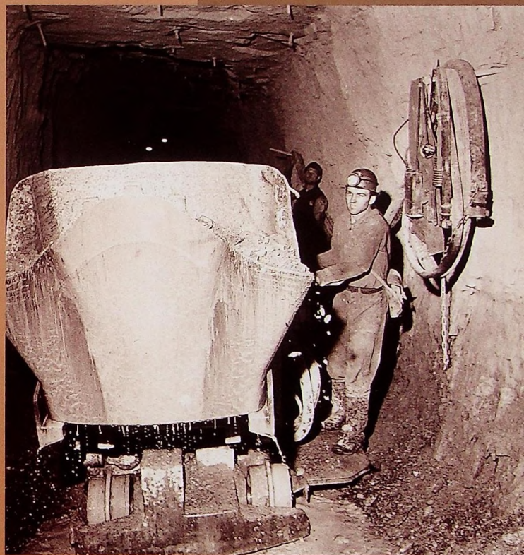
Ładowarka zasięrutna podczas drążenia pierwszych wyrobisk chodnikowych
