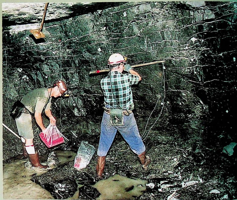
▲ Przygotowanie przodka do strzelania selektywnego
