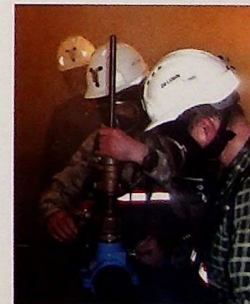
Nawiercanie otworu hydrantem nawiertowym.
