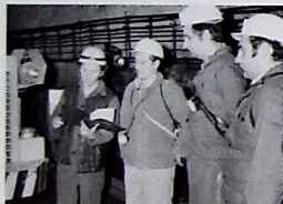
Przekazanie komory remontowej do CWR, od prawej: W. Kosmański, Z. Marcinkowski, S. Czerwien.
