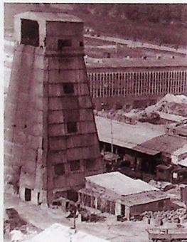
L-II w budowie, w tle budowa ZWR.
