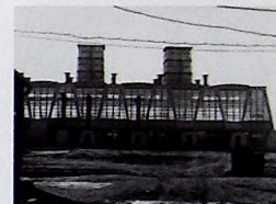
Stacja wentylatorów dla szybów L-IV i L-V.
