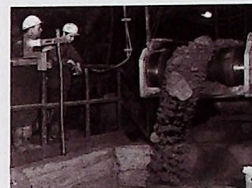
Stacja zrzutowa ostatniego przenośnika w diagonali WE2, L. Kasperek, J. Uniatowicz.
