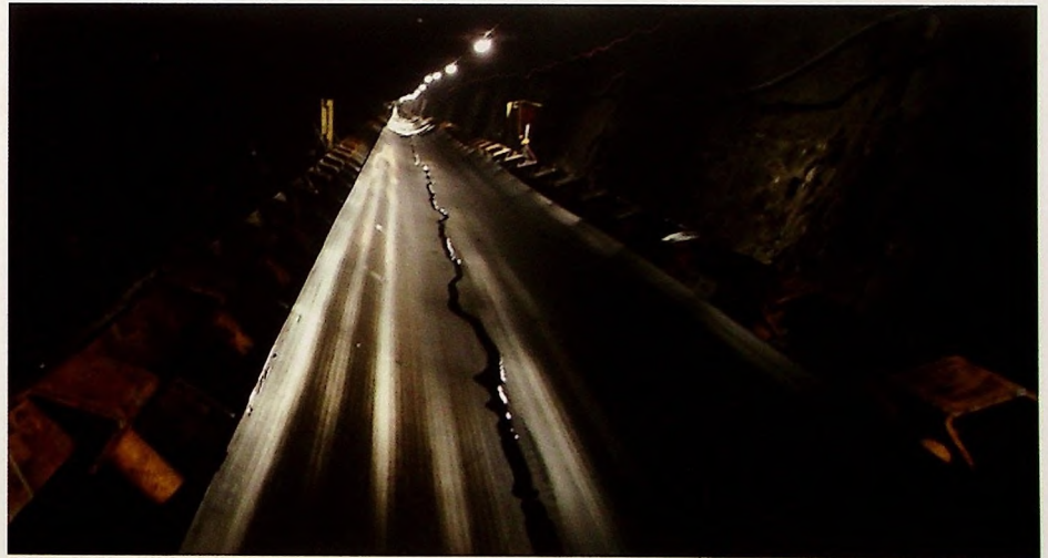
Przenośnik taśmowy A-183, w którym zastosowano wiele nowych rozwiązań m. in.: taśmę z okładką energooszczędną, nowy typ krążników dolnych i górnych, sprzęgło o zmiennym naplenieniu olejem: tzw. TPŁL z firmy Voith, silniki z magnesami stałymi, wkładki ceramiczne na okładkach bębnow napędowych.
