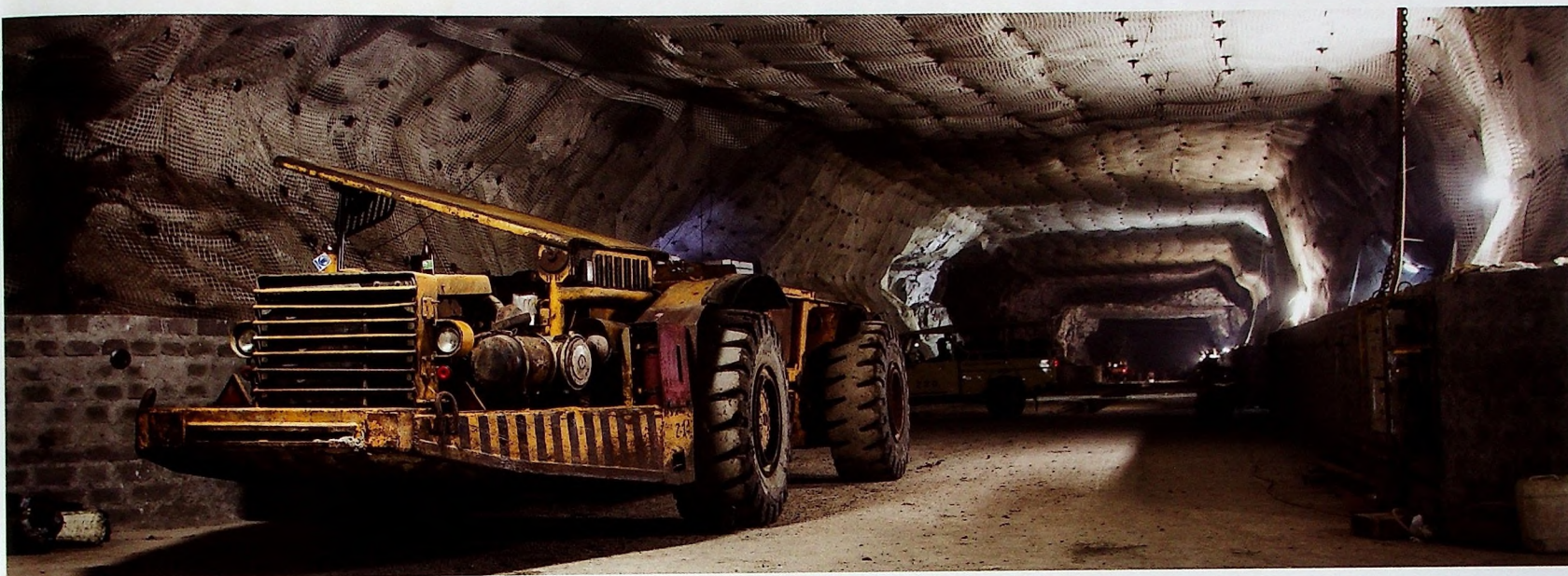
Nowa komora maszyn ciężkich, stan pracy na wrzesień 2017 r.
