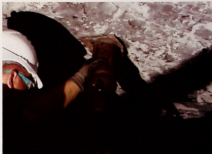
Badanie nośności kotew.
