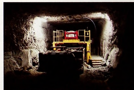
WS-171 na tle konstrukcji najazdowej.
