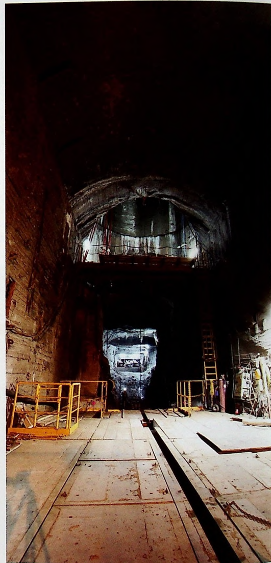
Prace modernizacyjne na podszybiu, wrzesień 2017.
