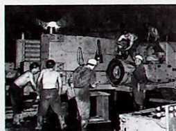
Montaż kruszarki WB-14 pod nadzorem L. Kasperka.
