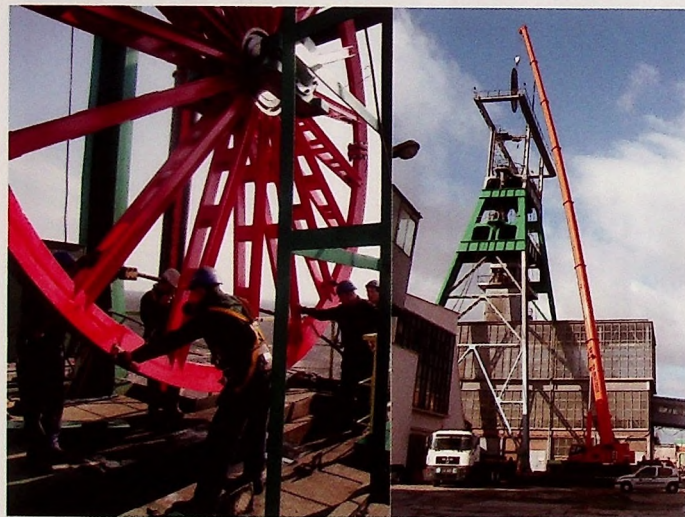
Wymiana kół linowych na wieży kółkowej szybu L-I.
