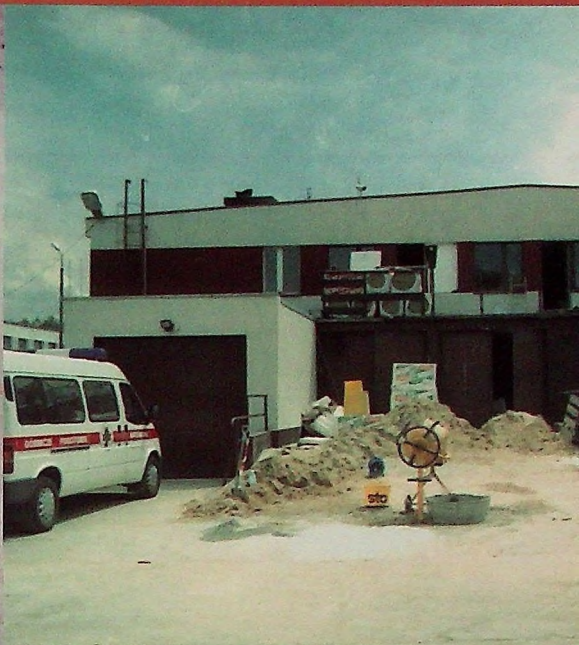
Rok 2000 początek remontu
