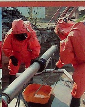
Strażacy z wydziału I uszczelniają rurociąg
