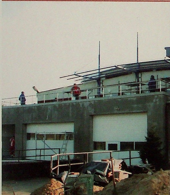
Rok 2000 remont w trakcie
