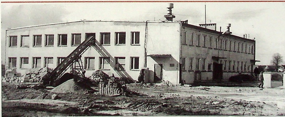
Remont obiektu byłej łaźni przy szybie P-7, który stał się siedzibą OSRG
