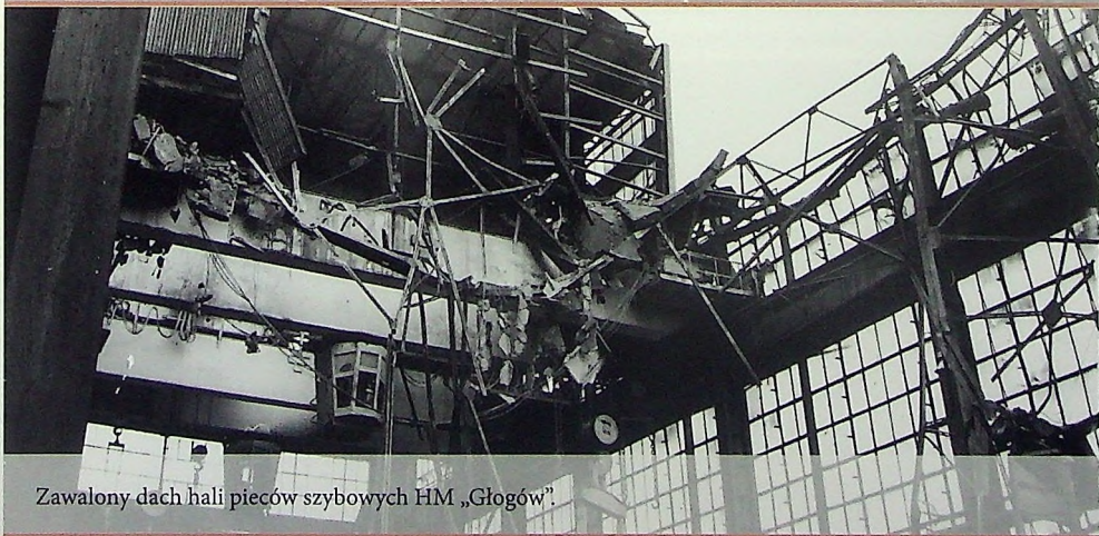
Zawalony dach hali pieców szybowych HM „Głogów”.
