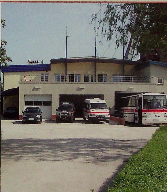
Rok 2000 po ukończeniu remontu obiektu
