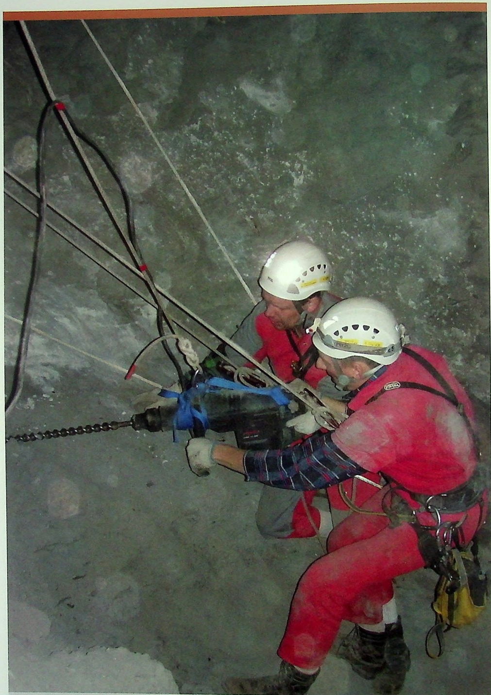
Ratownicy podczas prac profilaktycznych w zbiorniku retencyjnym
