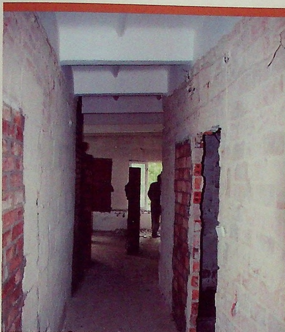
Po remoncie na końcu korytarza powstanie pokój kierowców, a nieco dalej klatka schodowa
