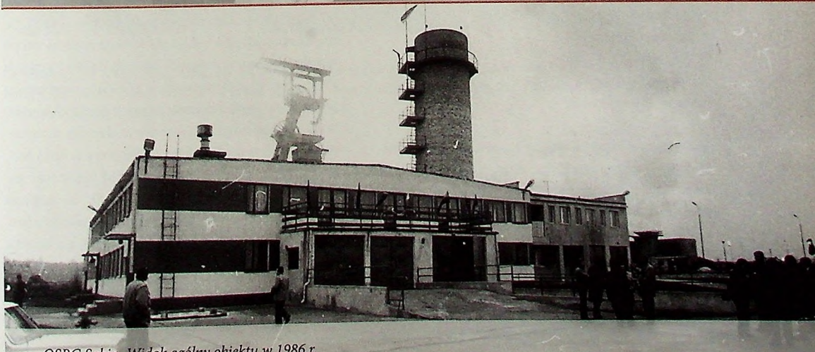
OSRG Sobin. Widok ogólny obiektu w 1986 r.
