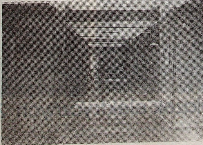
Tak prezentuje się wnętrze przychodni — zrealizowanej już części szpitala wojewódzkiego. Fot. Jerzy Kosinski
