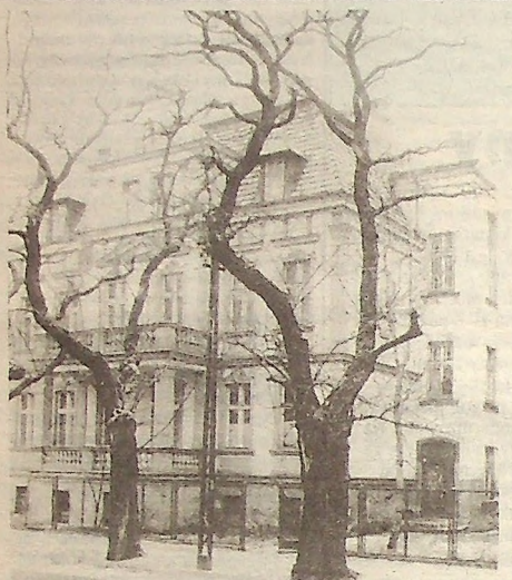
17. Dom był własnością Paula Hauboldta. Na parterze mieszkał kapitan Kurt Richter, na I piętrze właściciel, a na II piętrze wdowa A. Koch.
