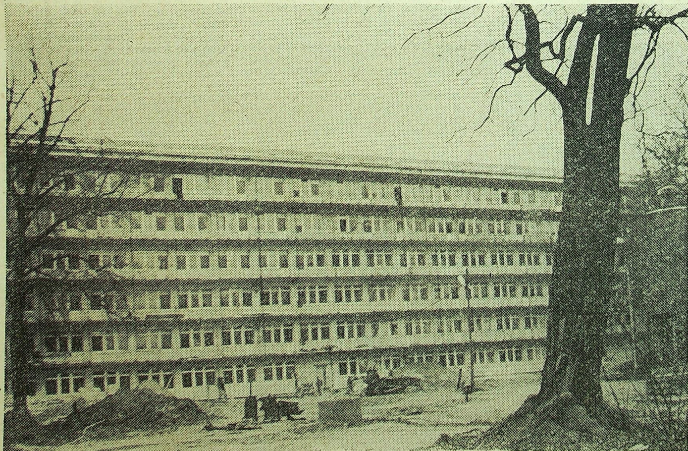
Tak wygląda obecnie jeden z budynków powstającego w przyspieszonym tempie szpitala powiatowego w Lubinie. Projektanci i realizatorzy obiektu potrafili zachować stary drzewostan otaczający poszczególne pawilony.
