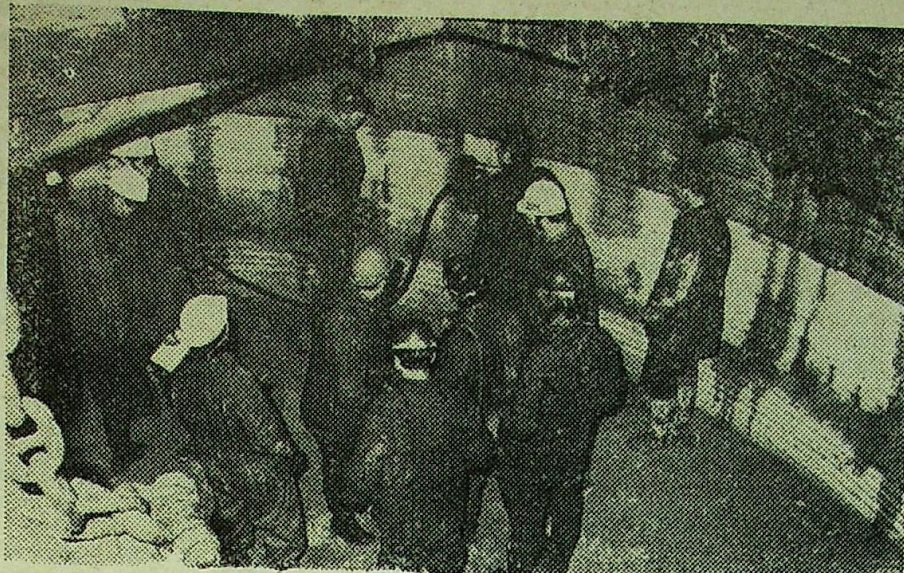
Dotychczas zamrożone skały urabiane ręcznymi młotami pneumatycznymi, dziś są to tylko narzędzia pomocnicze.
