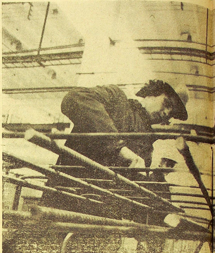
Edward Ładysz i Sylwester Dobrowolski (II klasa: betoniarni-zbrojarz) przy pracach w fabryce domów.
