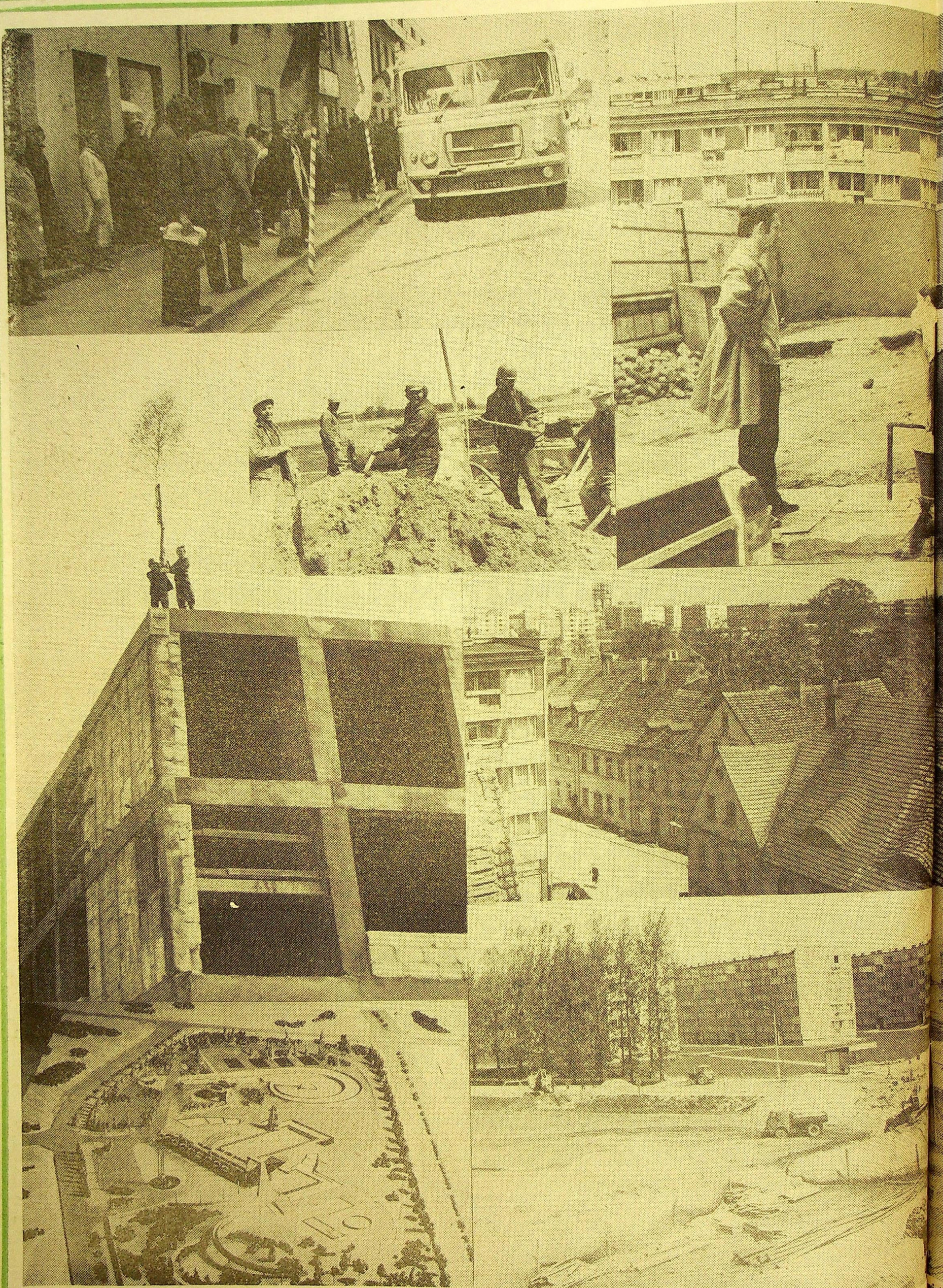
Na razie przystanek MPK i PKS znajduje się w rynku „pod chmurką”, ale już rozpoczęto budowę dworca z prawdziwego zdarzenia... W starej części miasteczka domów pozbawionych jest wody, pozostaje więc tylko uliczna pompa... W niespotykanym tempie wznosi się nowa szkoła. Po zaledwie siedemnaście dni trwania budowy na budynku zatknęto wiechę. Na zdjęciu współtwórcy sukcesu: Stefan Zagórski, Stanisław Wąsala, Piotr Choma i uczniowie ZSB Księginice Ryszard i Edward Rumin... Polkowice są wielkim placem budowy. Niebawem powstanie tutaj kompleks basenów kąpielowych (patrz makieta).
