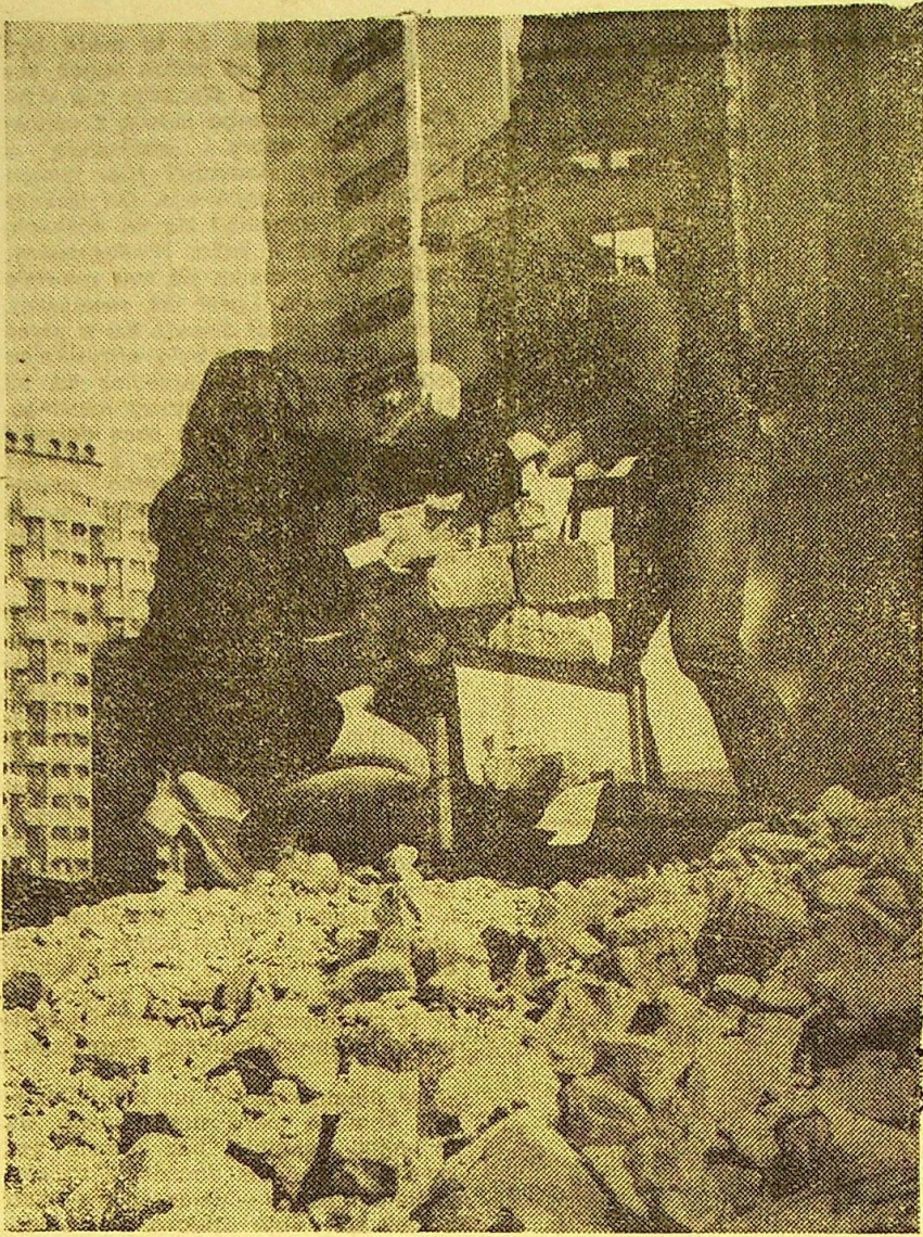
Wszyscy wiedzą, że szczęśliwego życia nie można budować na nieodpowiedzialnych obietnicach. A mimo to...
