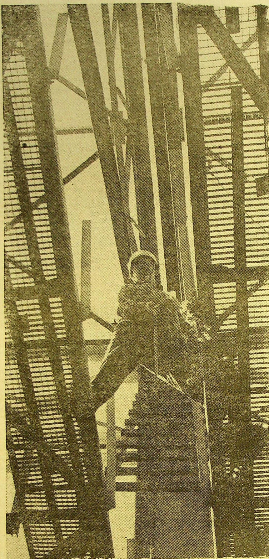
Praca na wysokościach nie jest łatwa ani bezpieczna. Na zdjęciu, lubiany i ceniony przez kolegów, znakomity fachowiec – monter konstrukcji stalowych – Bronisław Psuja.
